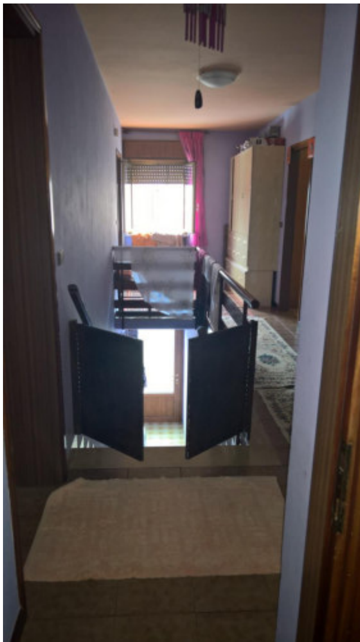
Foto n. 7 – Comune di Vivaro (PN), Foglio 19, particella n°93 sub 16 – Veduta generale del corridoio posto al primo piano dell'unità.
