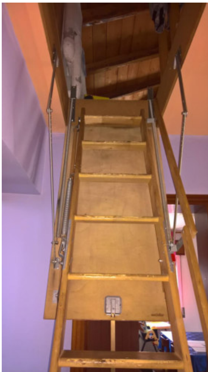
Foto n. 16 – Comune di Vivaro (PN), Foglio 19, particella n°93 sub 16 – Particolare delle scale a scomparsa per l'accesso alla soffitta.
