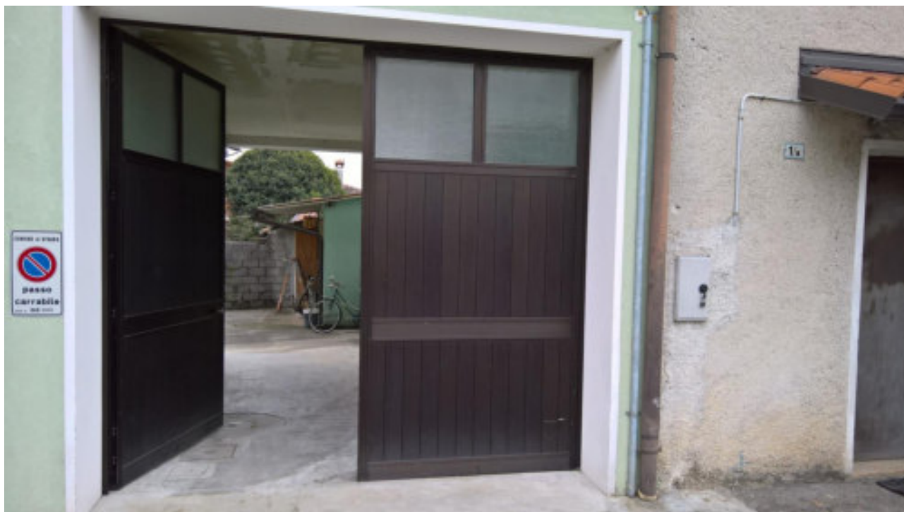
Foto n. 20 – Comune di Vivaro (PN), Foglio 19, particella n°93 sub 16 – Veduta esterna del portico facente parte del compendio pignorato.
