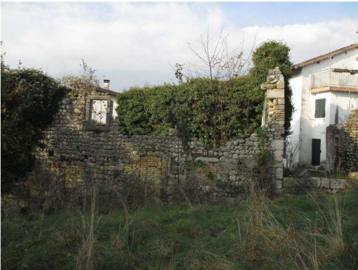
58) Veduta d'insieme del fronte sud-est
