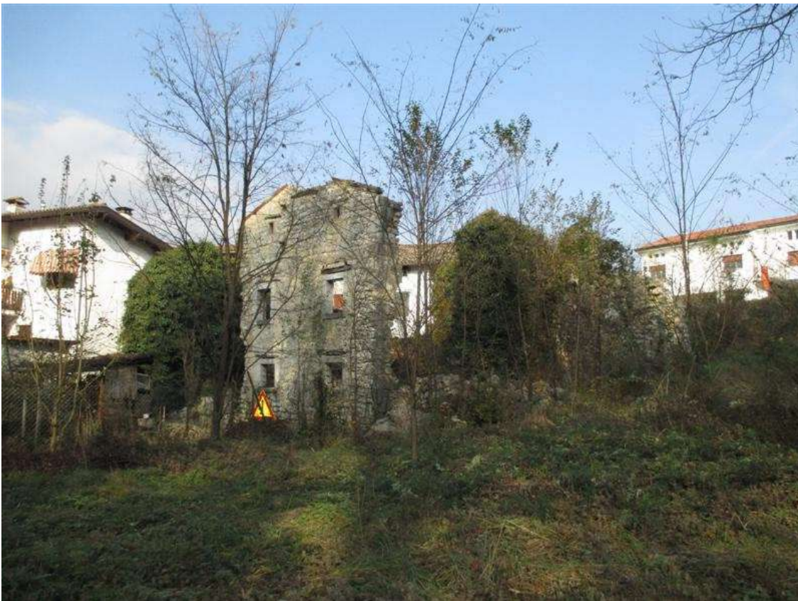
46) Veduta dei fronti sud-ovest e sud-est del fabbricato dal terreno antistante
