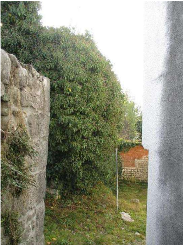
33) Rampa di accesso
