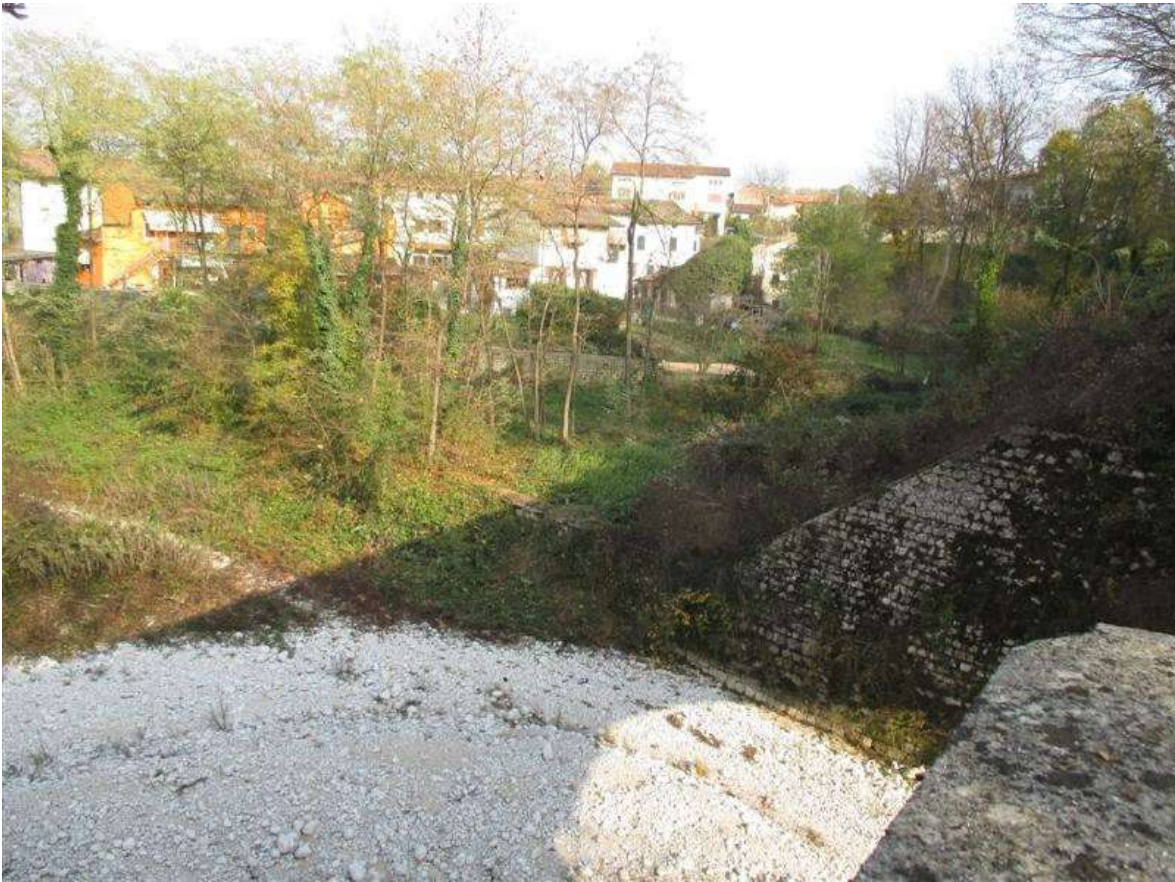
7) Vedute del torrente da via Ortugna
