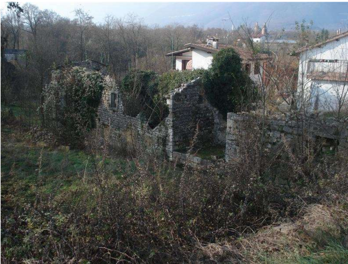
29) Vedute del fabbricato rudere dalla strada
