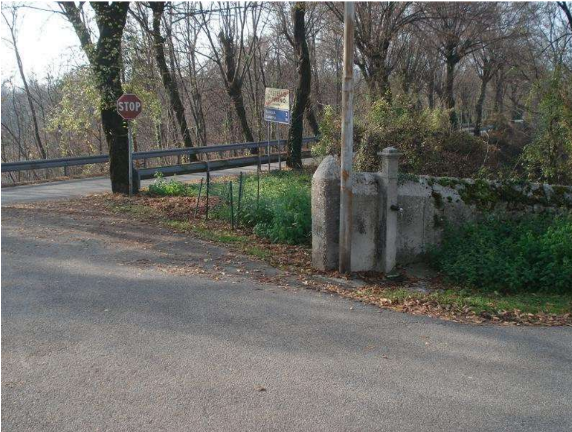
17) Particolari del muro di cinta del terreno su via per l'Ortugna
