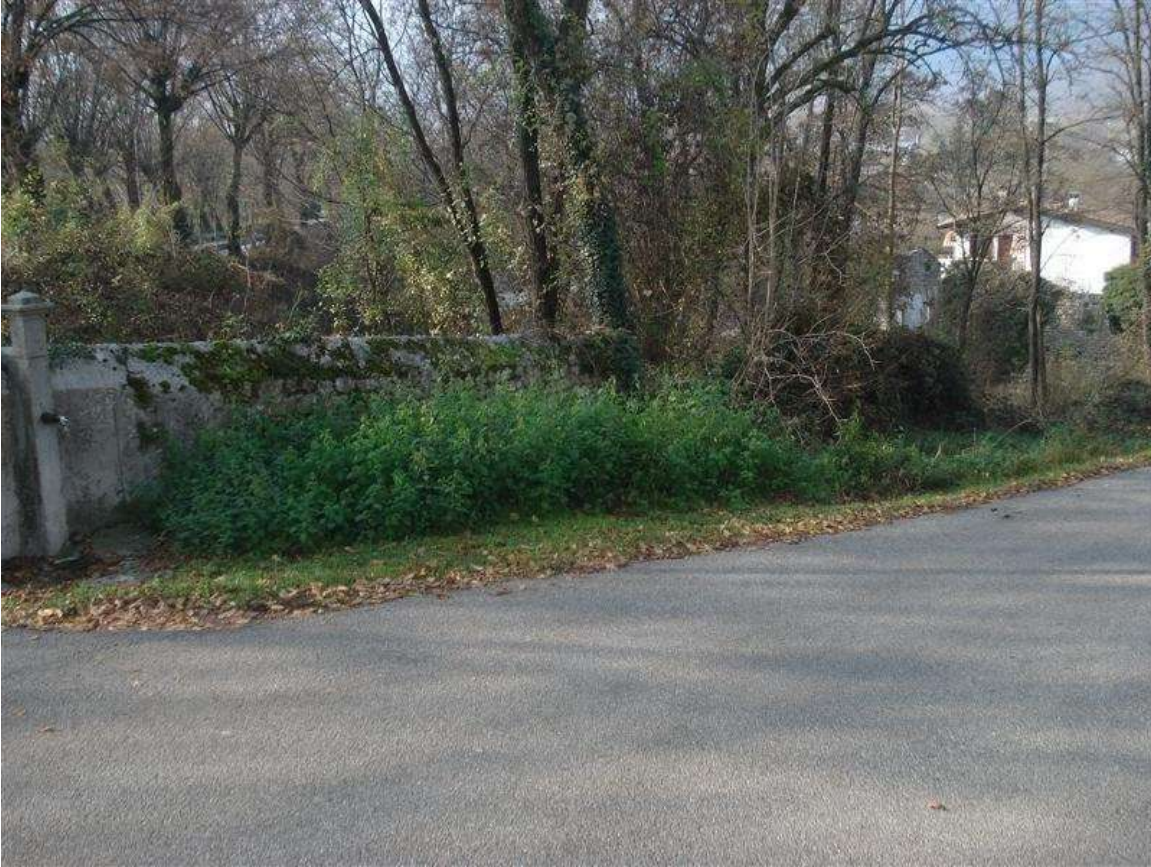
19) Vedute del muro di cinta del terreno dalla strada via per l'Ortugna
