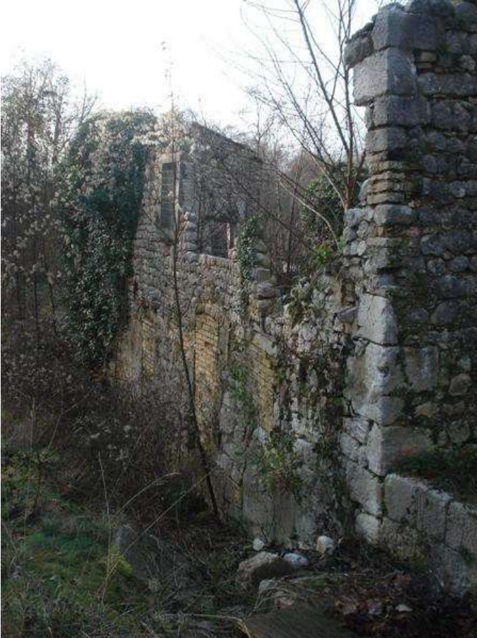
69) Particolari della sede della ex roggia, adiacente al fronte sud-est
