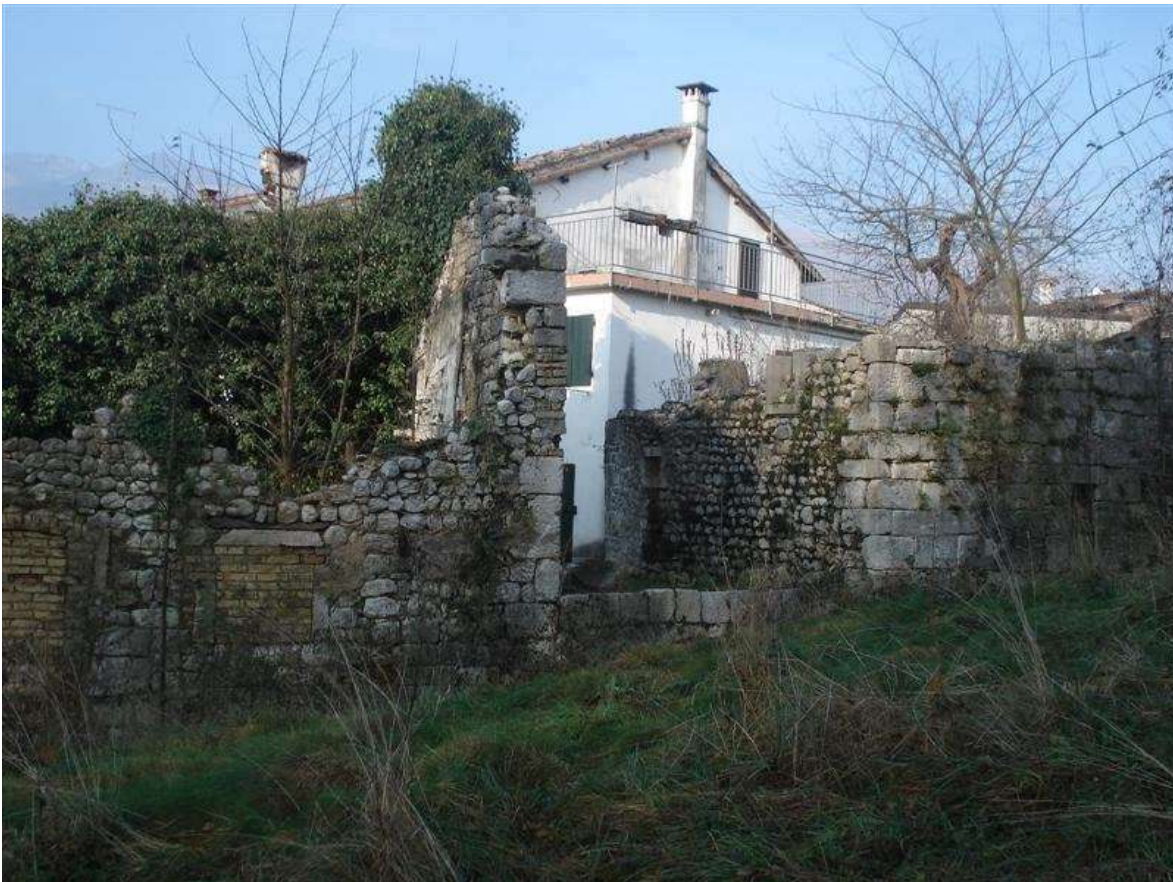
62) Veduta dell'angolo nord-est del fabbricato e del passaggio sulla ex roggia
