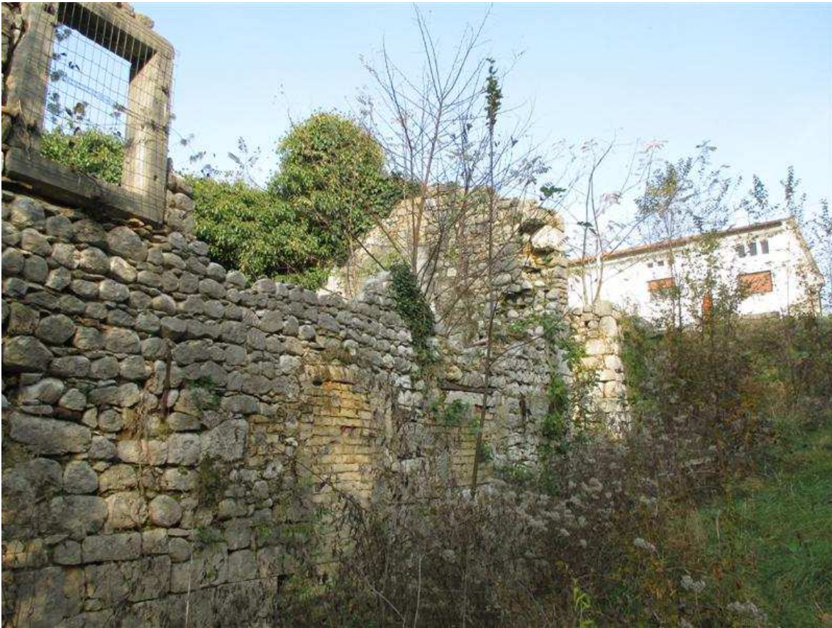
61) Particolare della muratura del fronte sud-est
