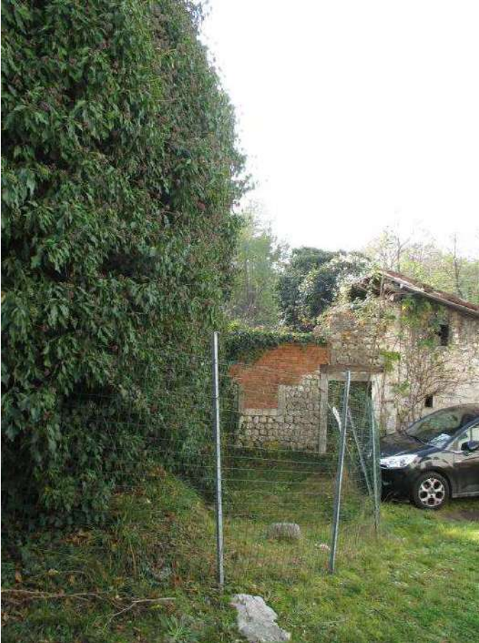
37) Angolo nord-ovest del fabbricato, ricoperto da vegetazione
