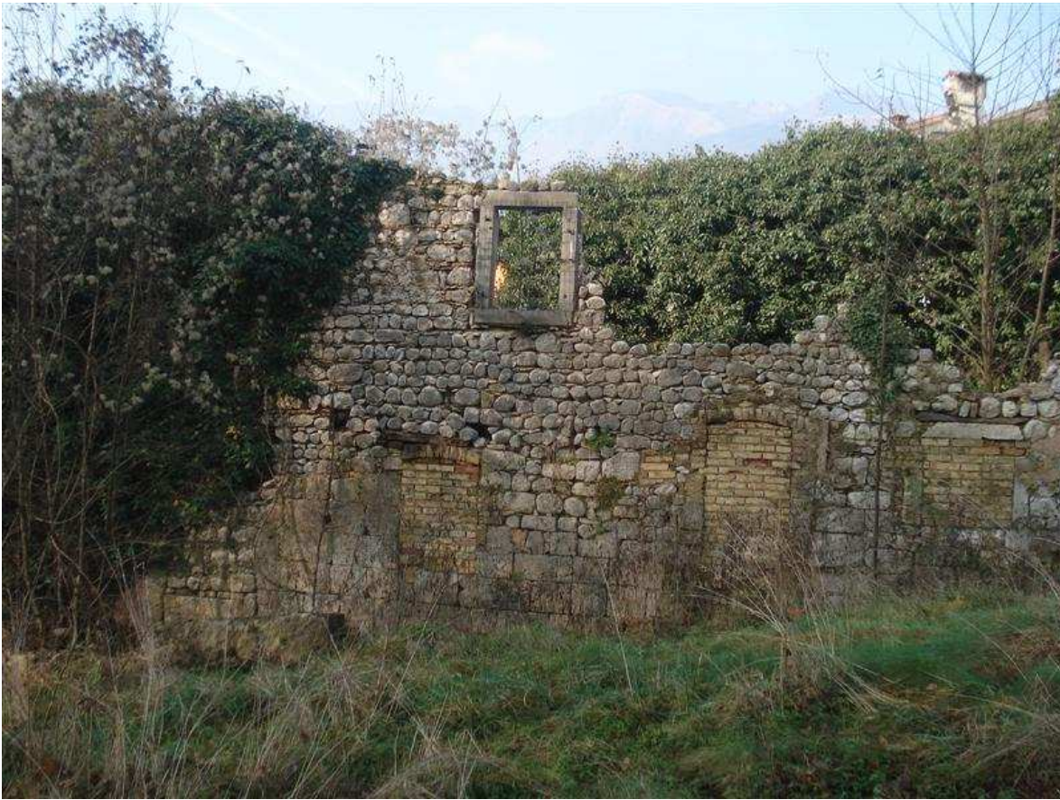
59) Particolari della muratura del fronte sud-est
