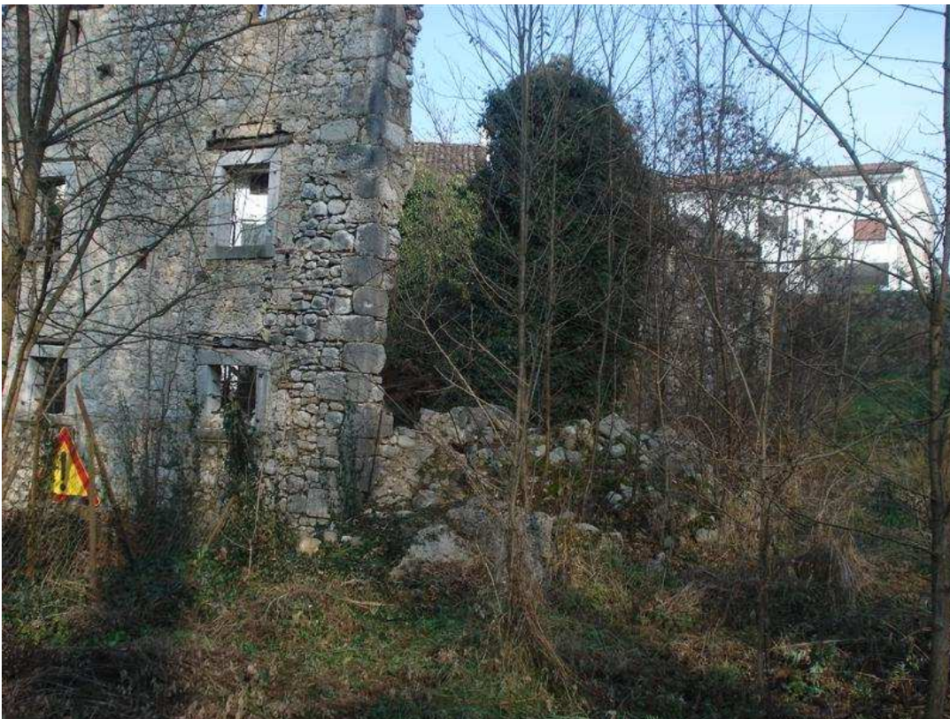
48) Particolare della muratura nell'angolo sud-est
