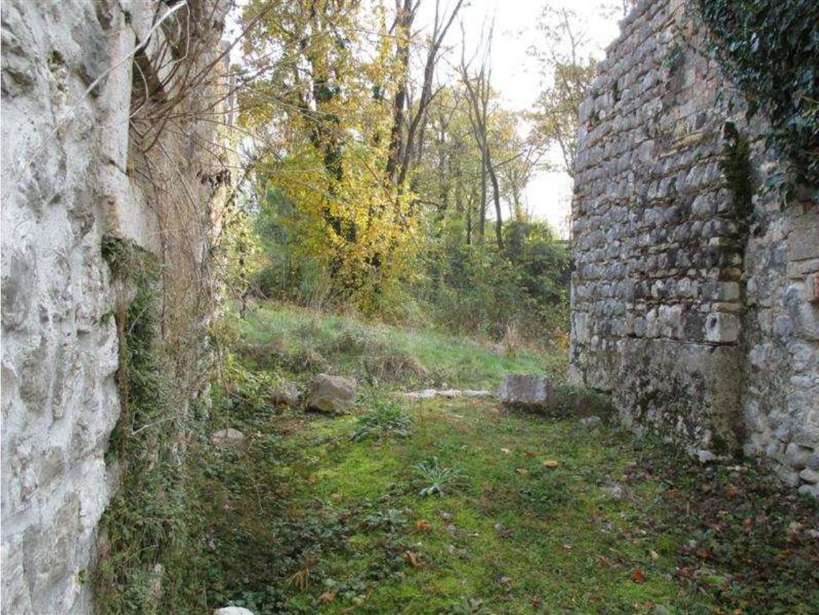
35) Fronte nord-est del fabbricato
