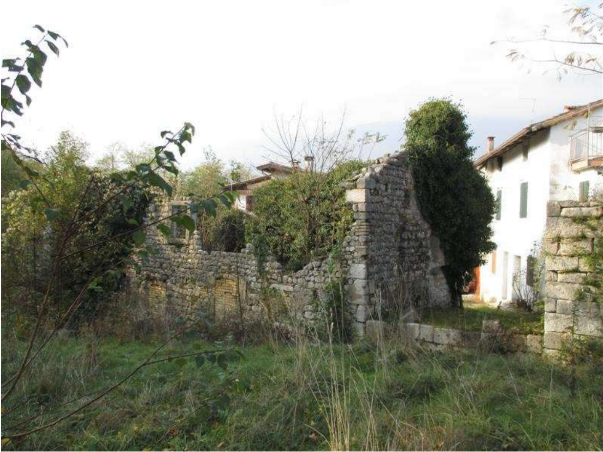
63) Veduta dell'angolo nord-est del fabbricato e del passaggio sulla ex roggia
