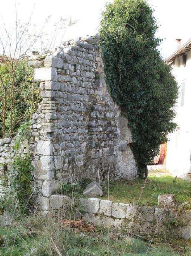
71) Particolari della sede della ex roggia, adiacente al fronte sud-est
