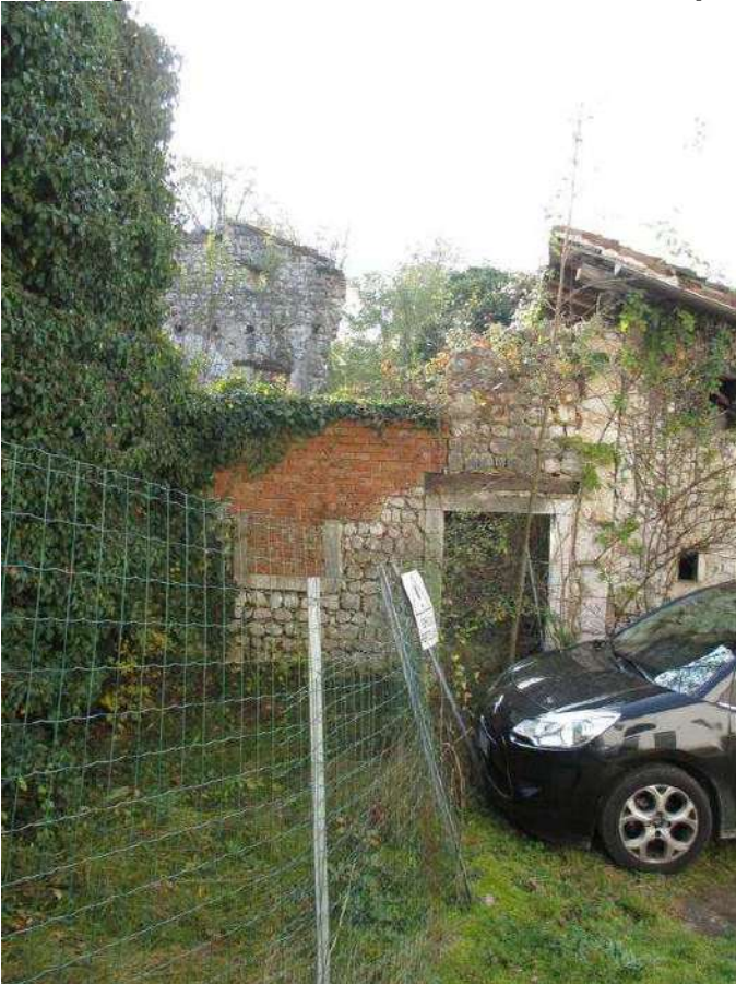
38) Fronte nord del fabbricato, con varco di ingresso
