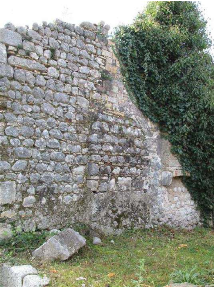
73) Particolari della muratura del fronte nord-est
