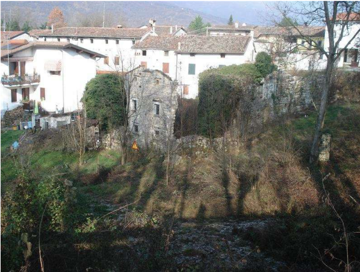
9) Veduta dei fronti sud-est del fabbricato rudere da via Ortugna
