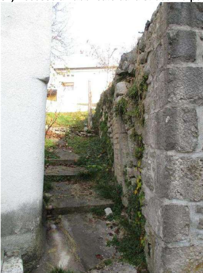
32) Rampa di accesso
