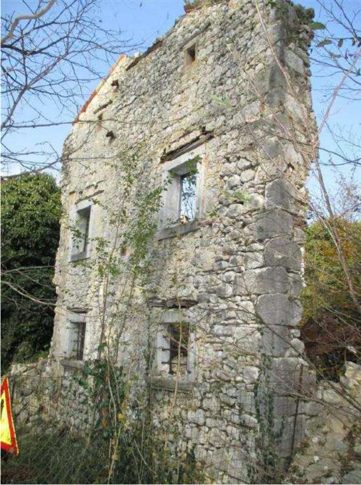
49) Particolare della muratura nell'angolo sud-est
