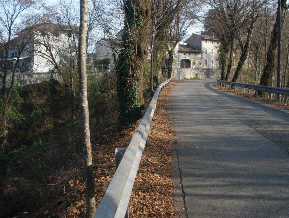
13) Vedute della scarpata lungo via Ortugna
