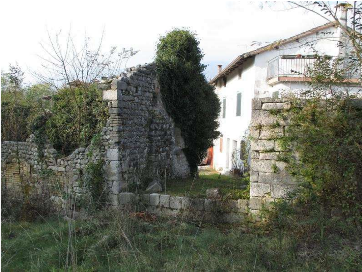
67) Angolo nord-est e fronte sul passaggio adiacente alla ex roggia
