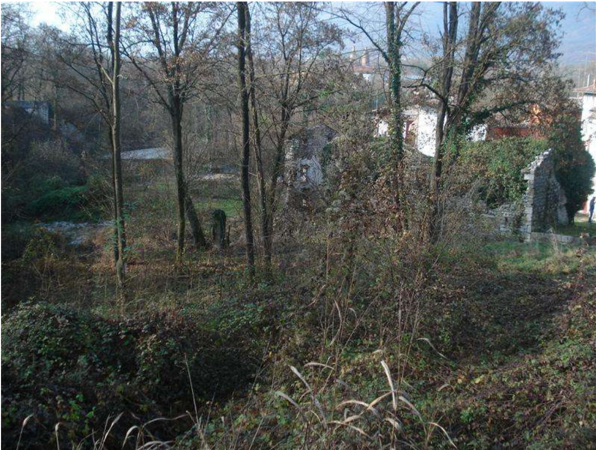
27) Vedute d'insieme del terreno e del fabbricato rudere dalla strada
