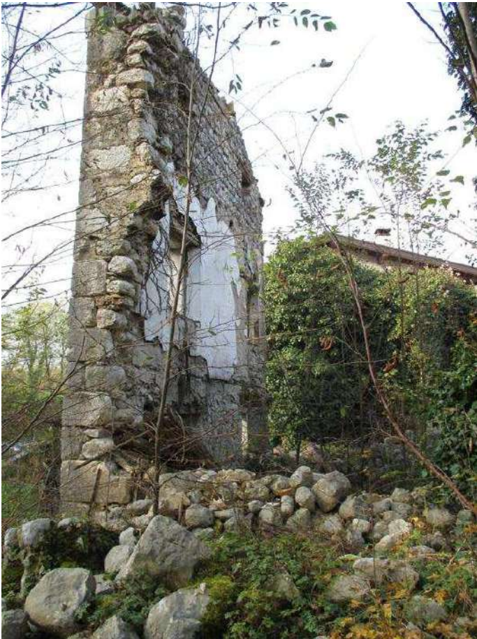
55) Particolari dell'angolo sud-est
