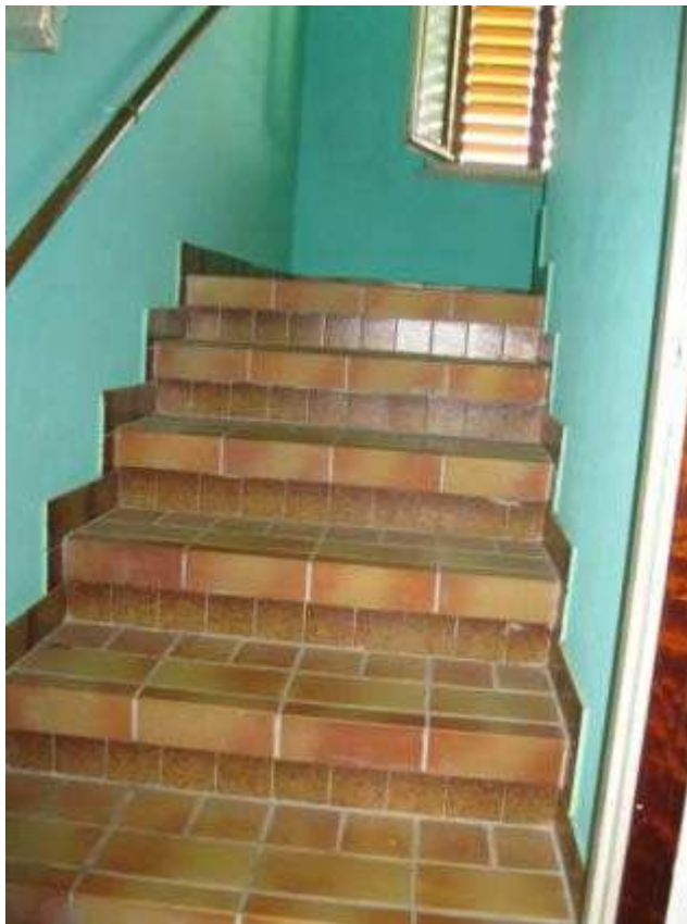
Foto 21 Scala di collegamento primo piano a secondo piano
