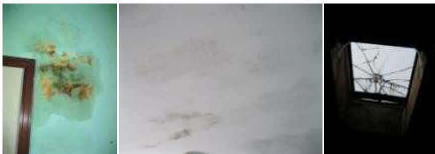
Foto 36-37-38 Interventi di manutenzione urgenti
