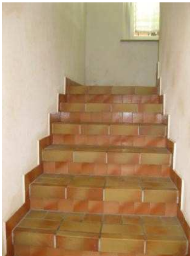
Foto 15 Scala da piano terra a primo piano
