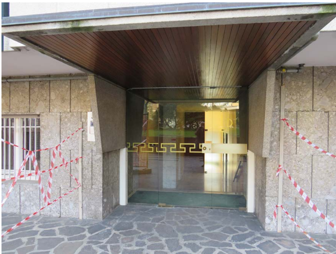
PORTONCINO DI INGRESSO SCALA D
