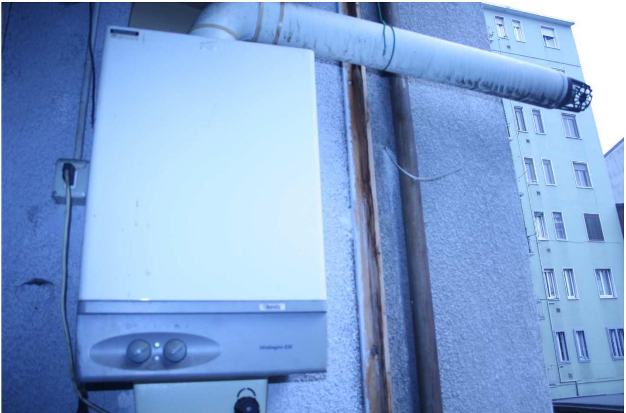
**19-20. Il balconcino del soggiorno e la caldaia istantanea a gas per la produzione di acqua calda sanitaria ubicata sulla parete esterna**
