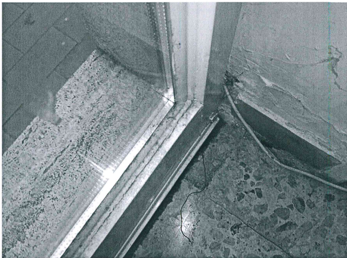
Dettaglio sostituzione vetro
