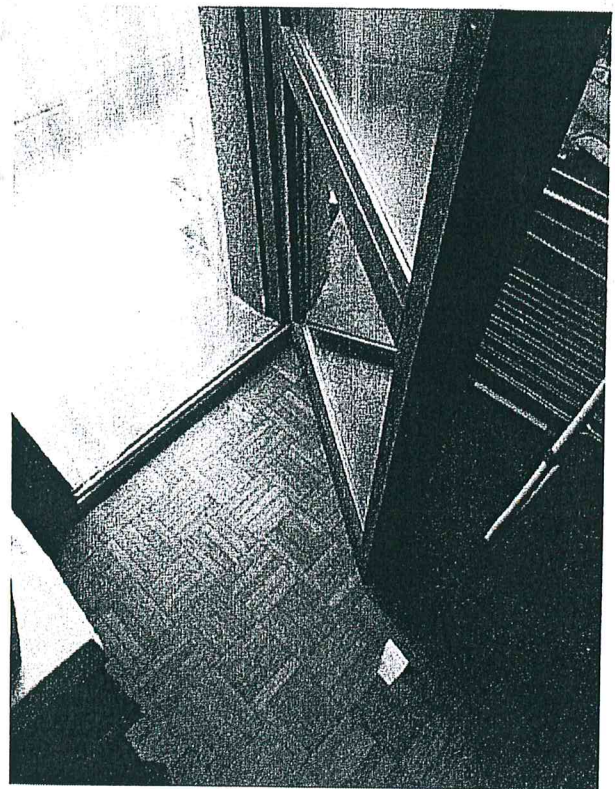
Particolari della pavimentazione in tasselli di rovere relativa alla prima camera da letto; infissi esterni in legno con doppi vetri, persiane scorrevoli in P.V.C. con installazione di zanzariere.
