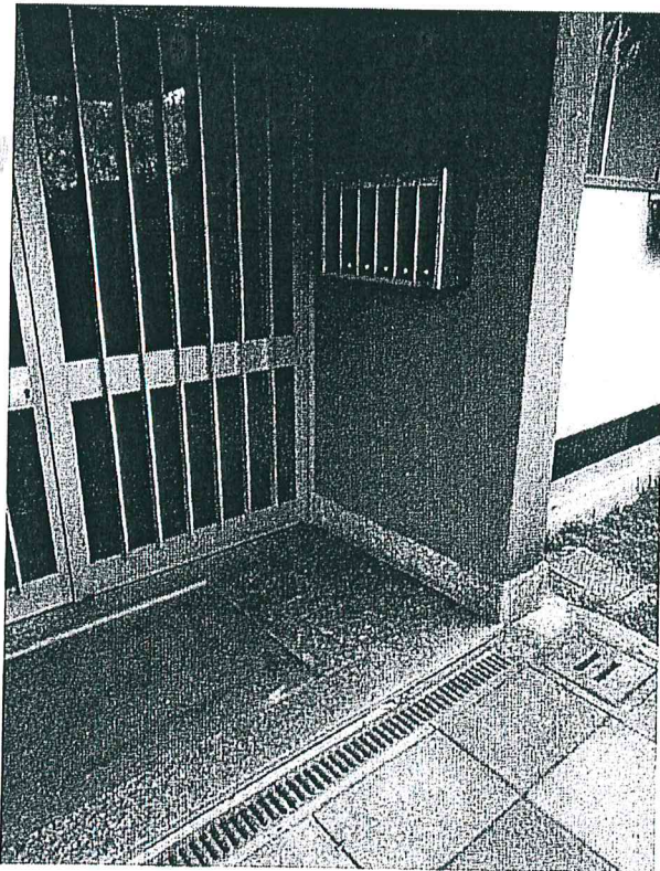
Particolare del portone d'ingresso all'atrio della scala C / 3 realizzato in alluminio e vetrato. Particolare del balcone di proprietà, sul fronte est, in affaccio su giardino comune; pavimentazioni in granito, c.l.s. e balaustre in c.a.
