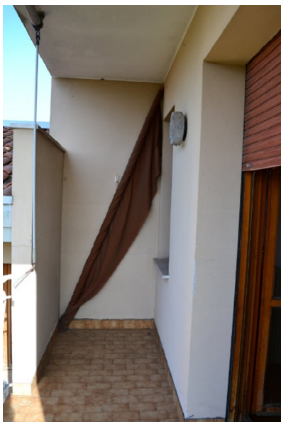
foto n. 15 – terrazzino fronte ovest
