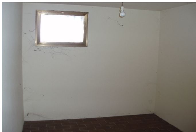
foto n. 15 – ripostiglio/cantina al piano terra
