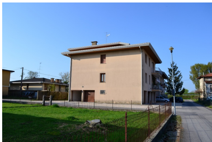
foto n. 2 – condominio - prospetto est
