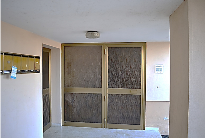
foto n. 7 – ingresso Scala B
