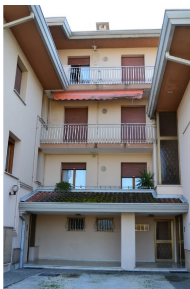
foto n. 6 – prospetto nord – portico condominiale con ingresso Scala A Scala B
