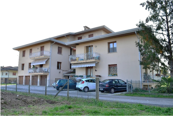
foto n. 1 – condominio - prospetto nord
