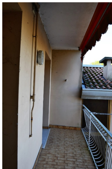
foto n. 14 – terrazzino fronte nord
