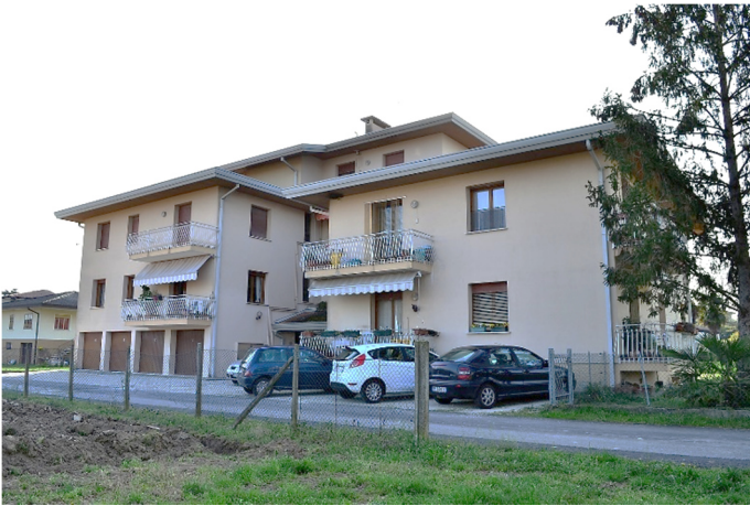
foto n. 1 – condominio - prospetto nord
