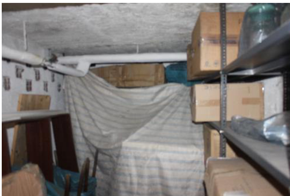
FOTO 12: MILANO, VIA F. RISMONDO 2, cantina
