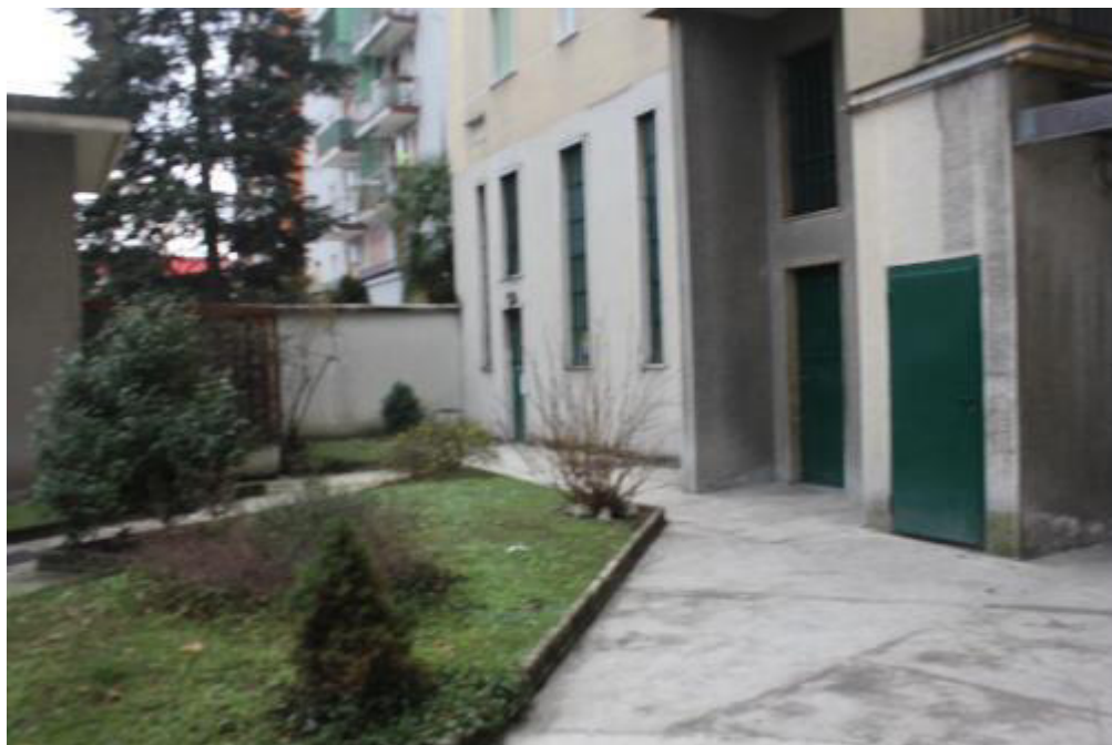
FOTO 2: MILANO, VIA F. RISSONDO 2, cortile condominiale
