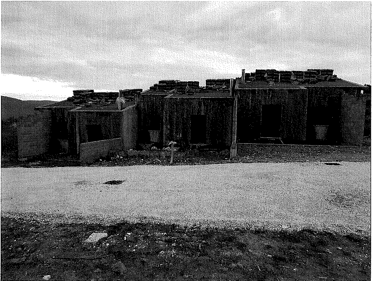
Edificio A: trifamiliare
