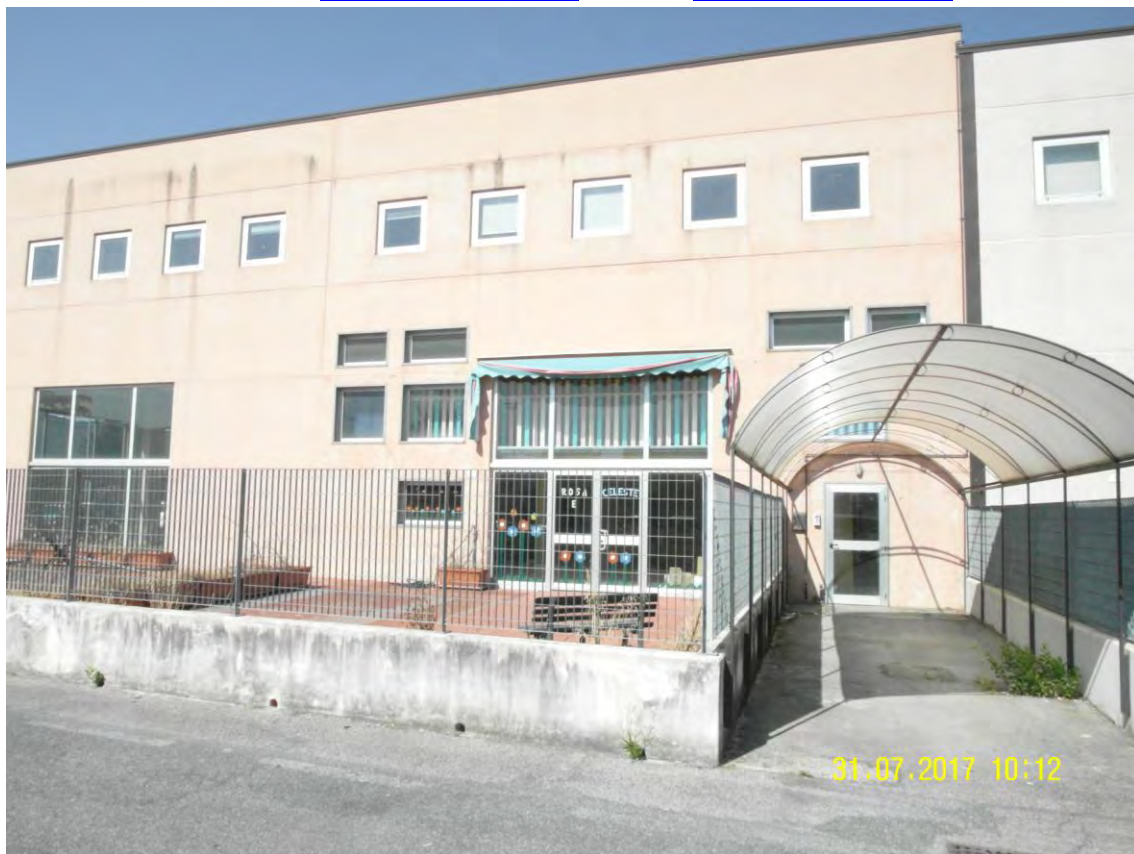
Foto n. 1: Accesso al fabbricato dalla via Bartocci.
