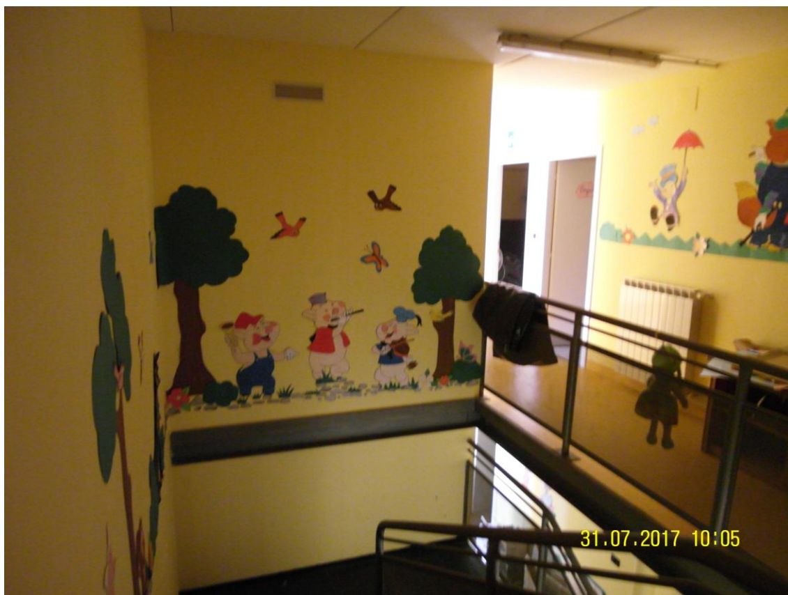
Foto n. 12: vano scala interna.
