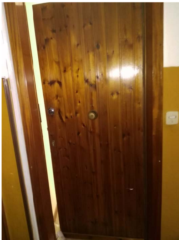
Dettaglio portone ingresso
