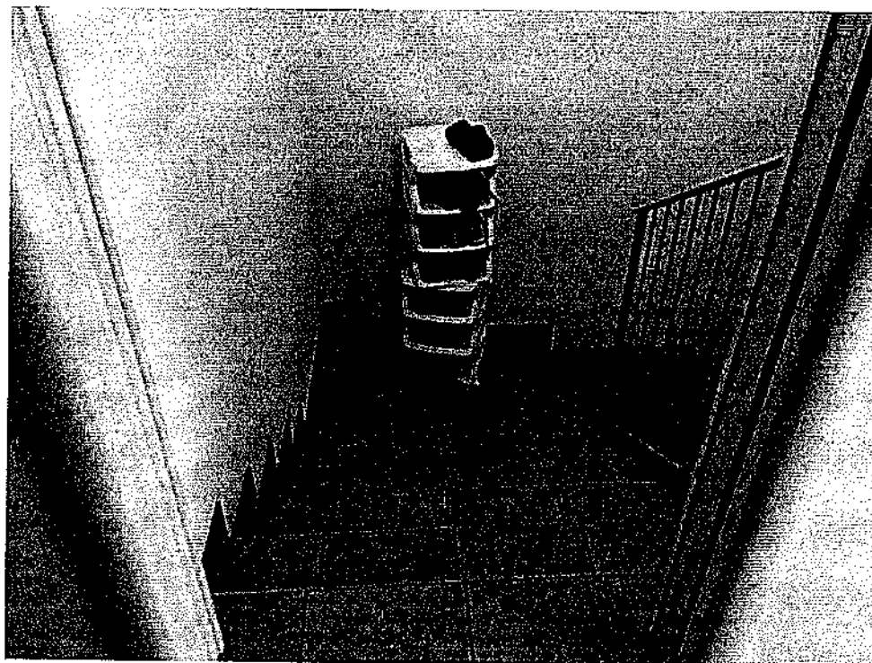
Foto 23: SCALA INTERNA DI COLLEGAMENTO PIANO TERRA – PIANO INTERRATO
