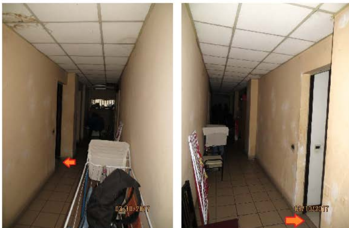
Foto 8/9 - Corridoio comune di accesso alle unità immobiliari.
