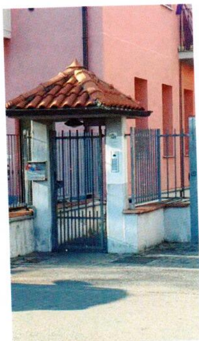
CANCELLO INGRESSO PEDONALE
