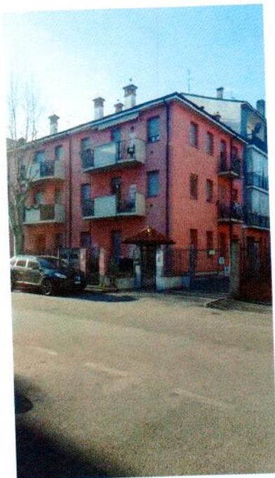
VIA PIEMONTE, 13/A- FACCIATA
