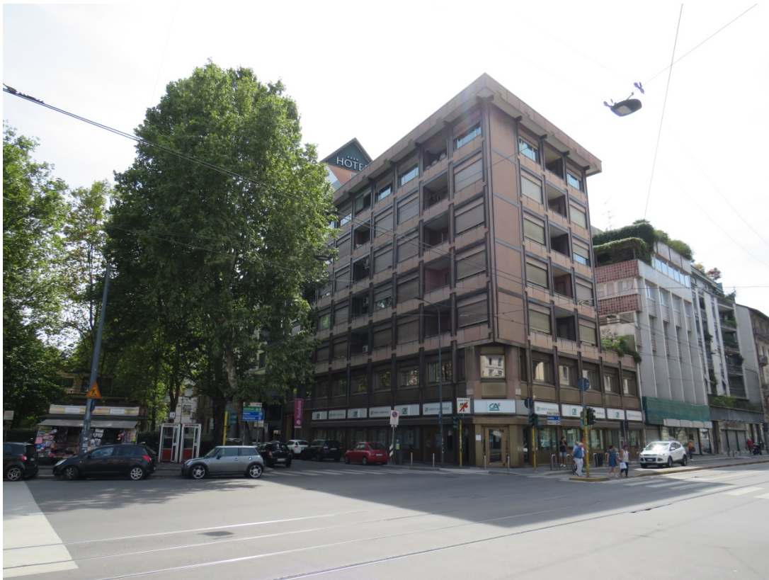
FACCIATA SU VIA CIMAROSA E CORSO VERCELLI
