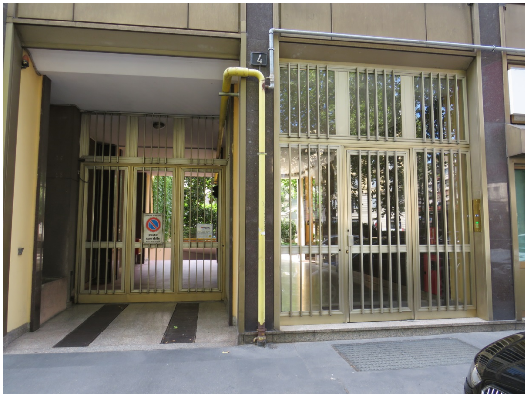
INGRESSO COMPLESSO IMMOBILIARE
