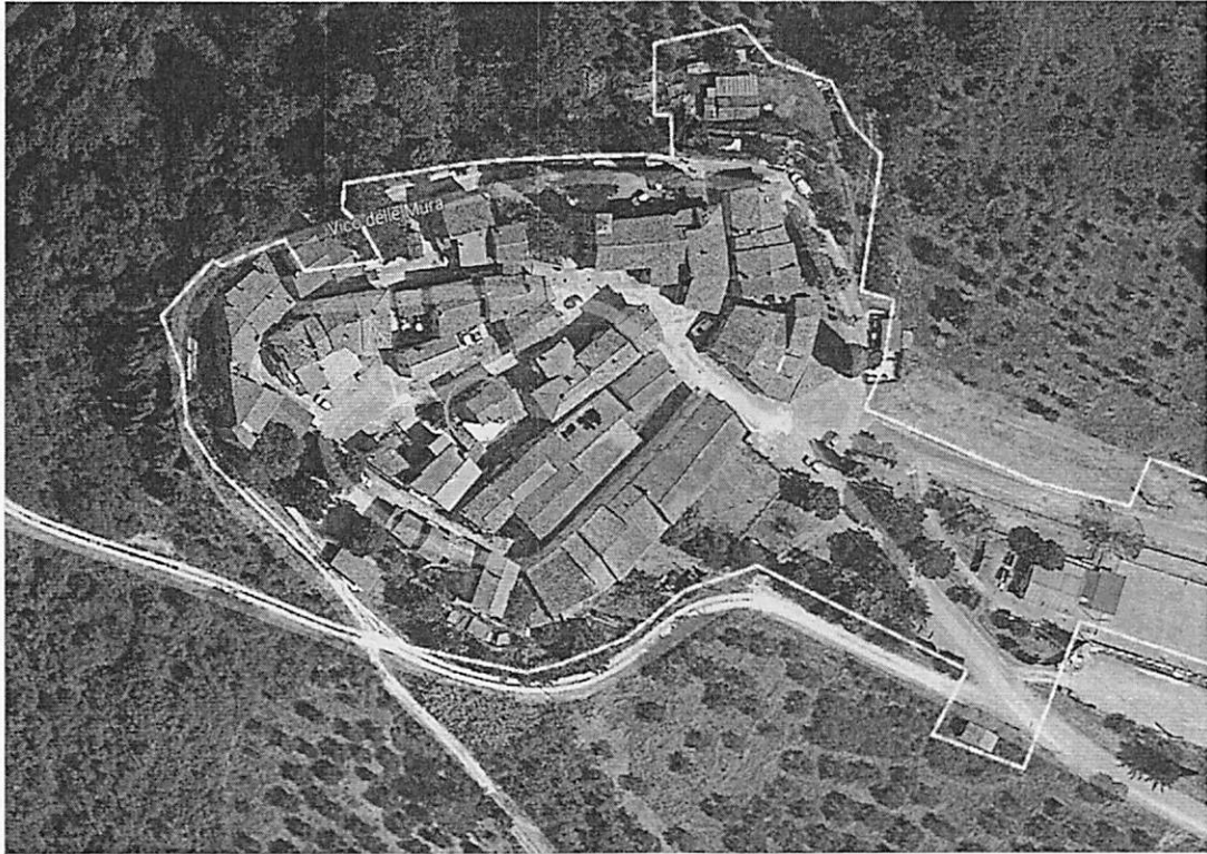
FOTO AEREA 1 (foto n.1)
