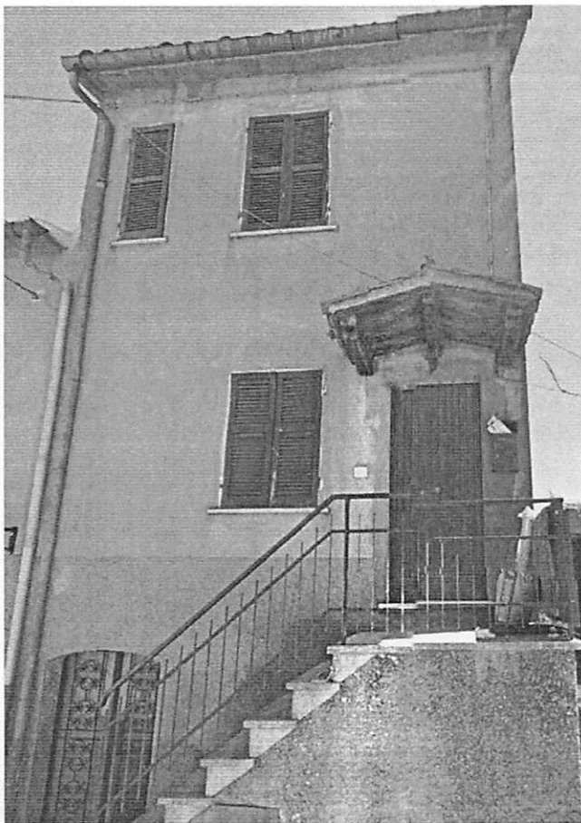
FOTO ESTERNO FABBRICATO 1 (foto n.2)
