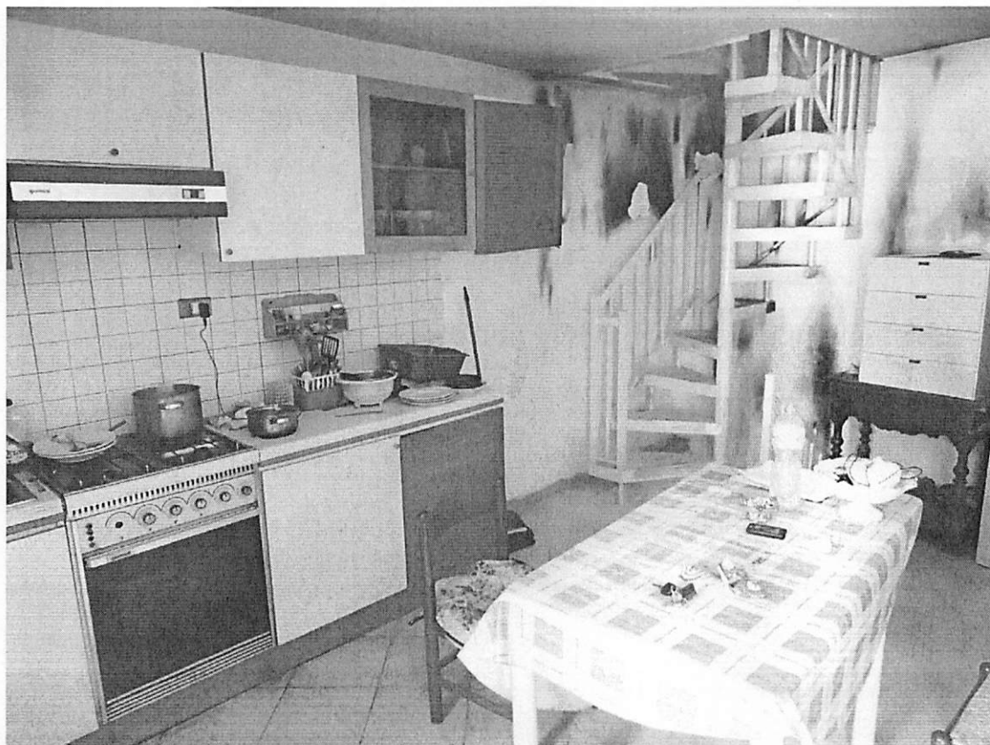
CUCINA – PIANO PRIMO (foto n.6)
