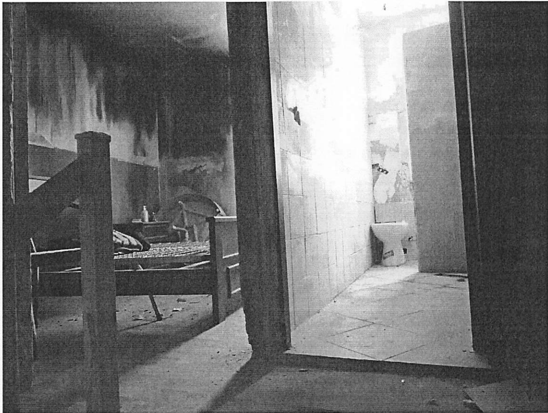
CAMERA, BAGNO – SECONDO PIANO (foto n.11)
