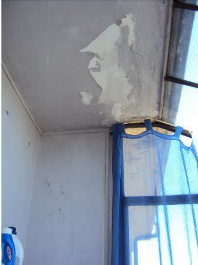
3P sub_8 15 Veranda su retro.JPG
