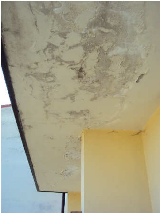
2P sub_6 12 Loggia su retro.JPG
