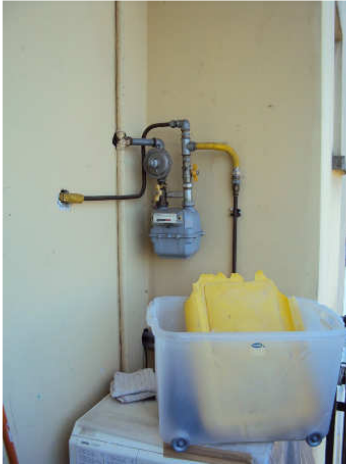
2P sub_6 11 Loggia su retro.JPG
