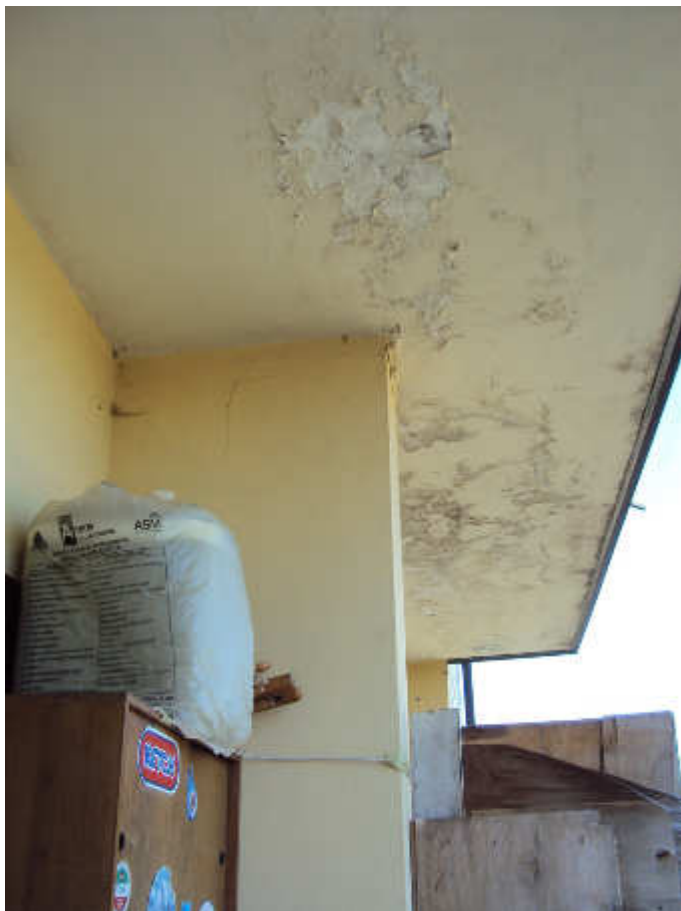
2P sub_7 12 Loggia su retro.JPG
