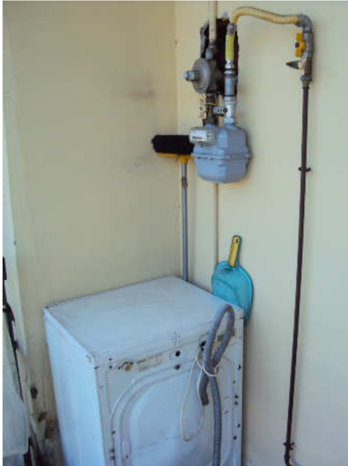
2P sub_7 11 Loggia su retro.JPG
