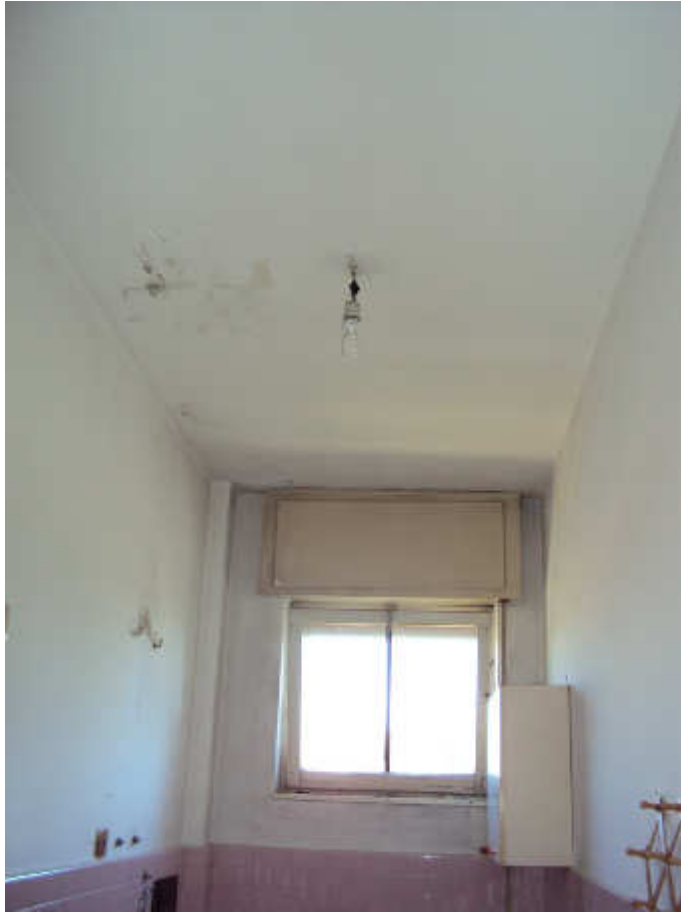
2P sub_7 07 Bagno.JPG
