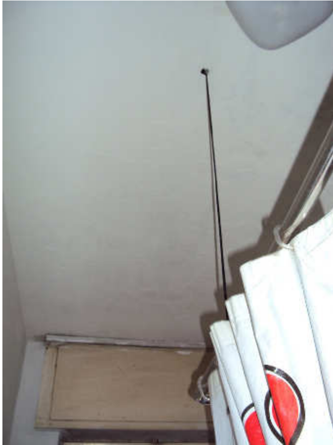
2P sub_6 07 Bagno.JPG
