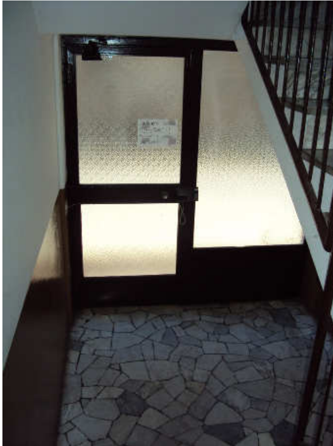
Ballatoio 03 Piano terra.JPG
