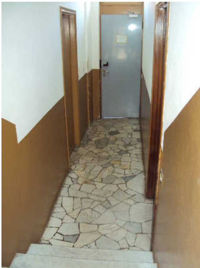
Ballatoio 04 PT Cantine.JPG
