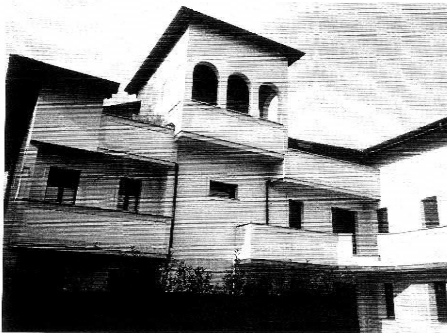
Foto 6 – Facciata a Nord su lato cortile
