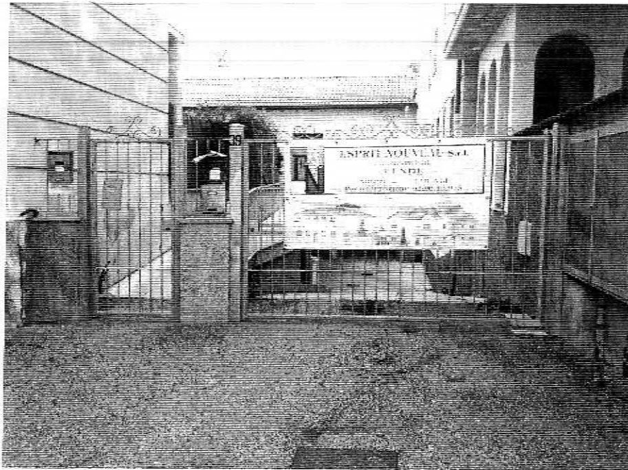
Foto 3 – Accesso carraio a piano interrato da Via Montebello
