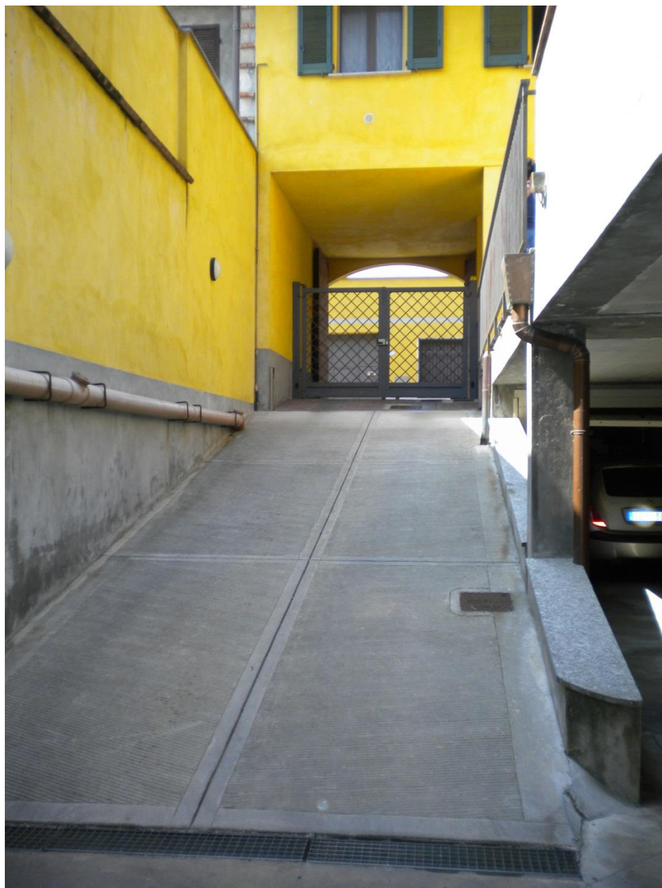
Foto 3 - Rampa di accesso al piano interrato
