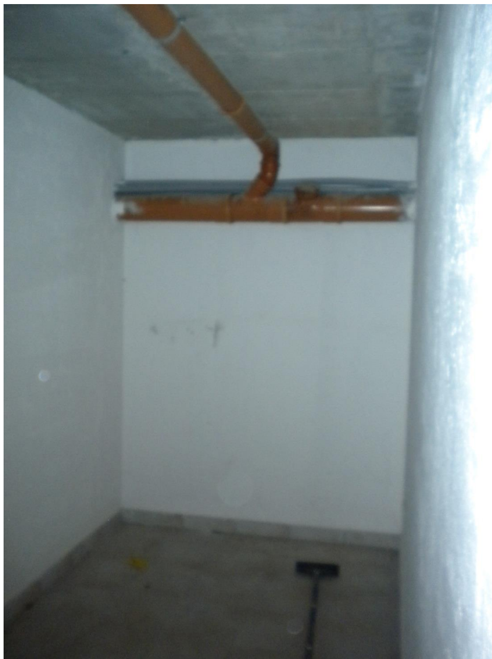
Foto 6 - Cantina_Vista interna (Lotto 9)
