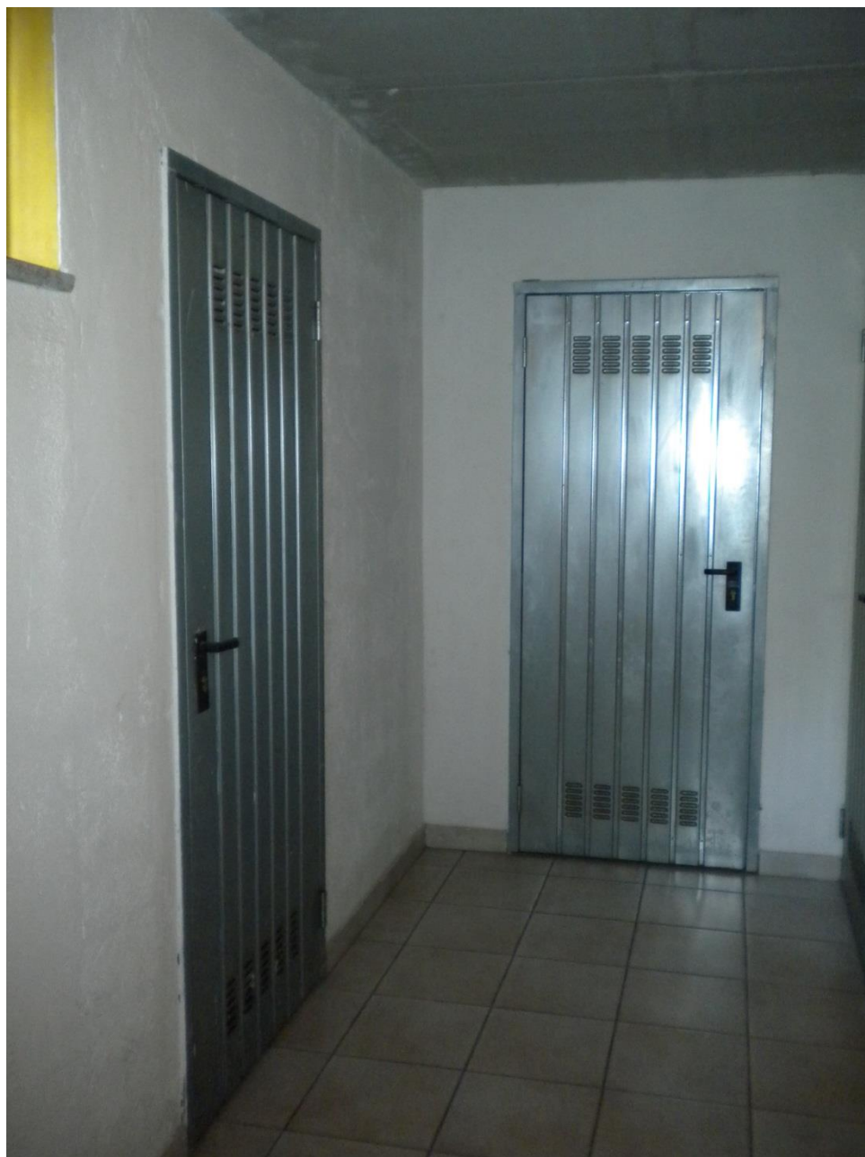
Foto 5 - Corridoio di accesso a cantine
