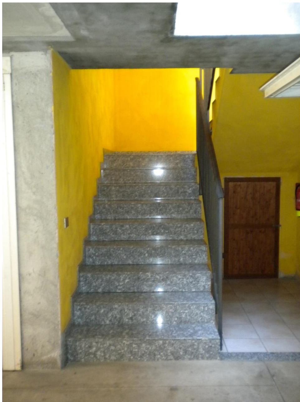
Foto 7 - Scala condominiale di accesso a piano interrato
