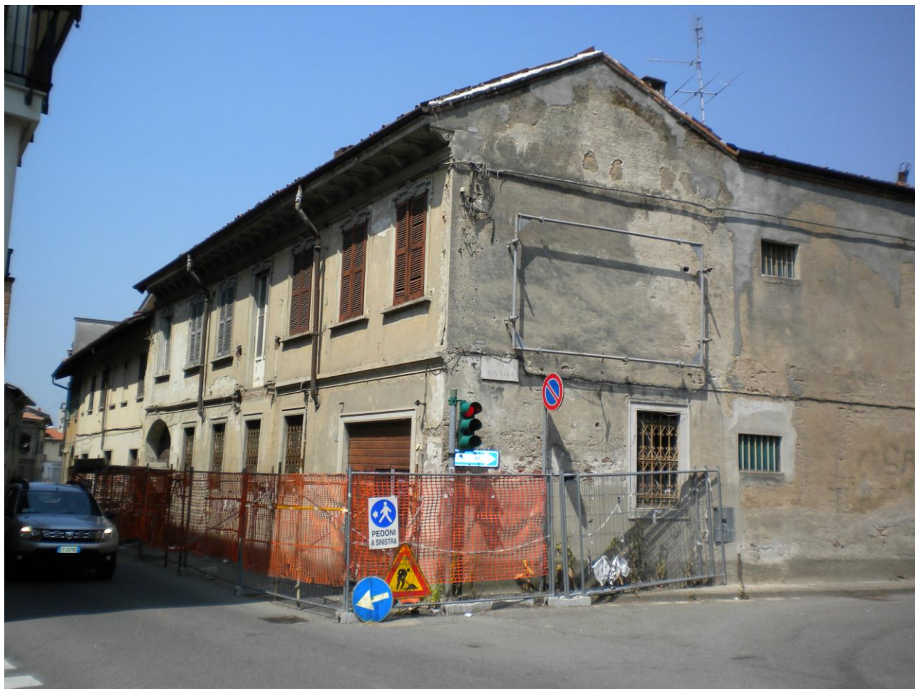
Foto 2 – Vista Lotto da Via XI Febbraio angolo Via San Luigi
