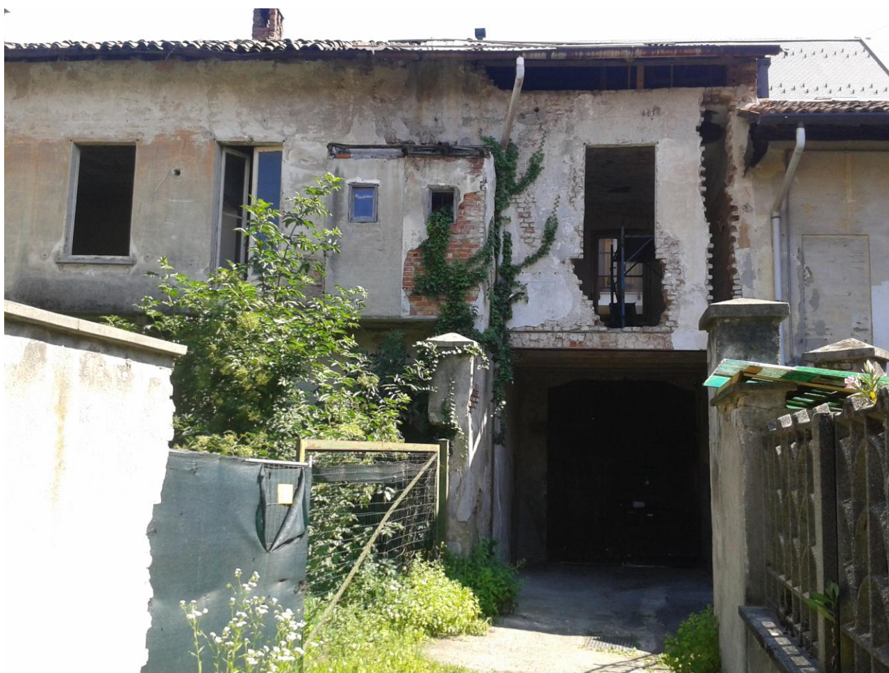
Foto 5 – Facciata Sud su cortile interno
