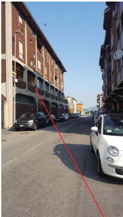
VIA C. BELGIOIOSO 24- FACCIATA
