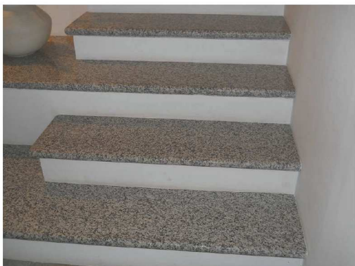
63. Scala di accesso al piano primo
