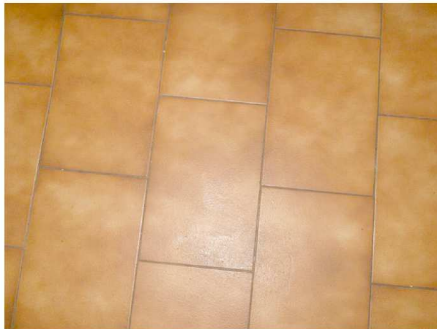
19. Pavimento del piano interrato
