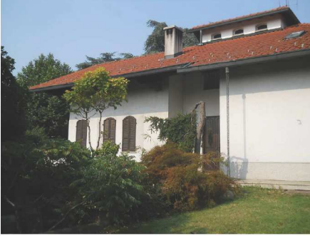
97. Facciata esterna in lato ovest
