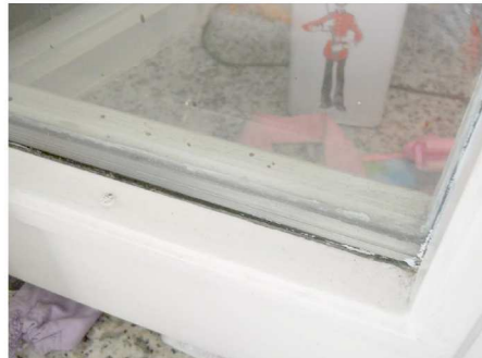
20. Particolare di un serramento esterno
