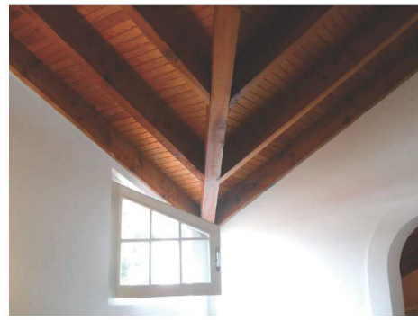
76. Particolare della copertura in legno
