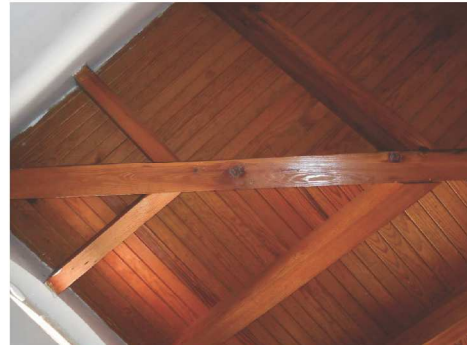
78. Copertura del corpo scala
