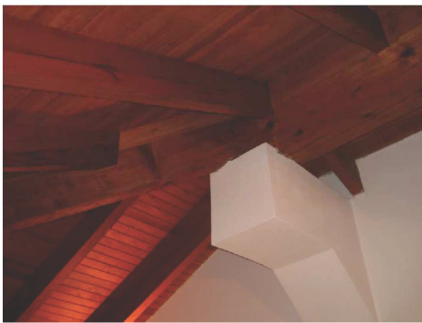
75. Particolare della copertura in legno
