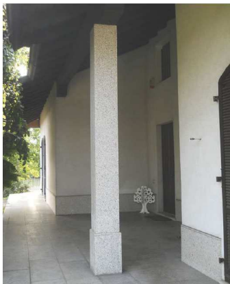
85. Portico di ingresso in lato sud
