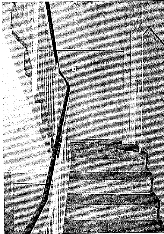
foto 4 particolare rampa scale
