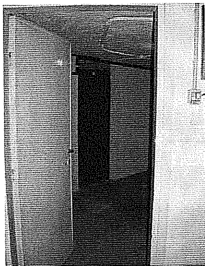
foto 13 accesso a cantina
