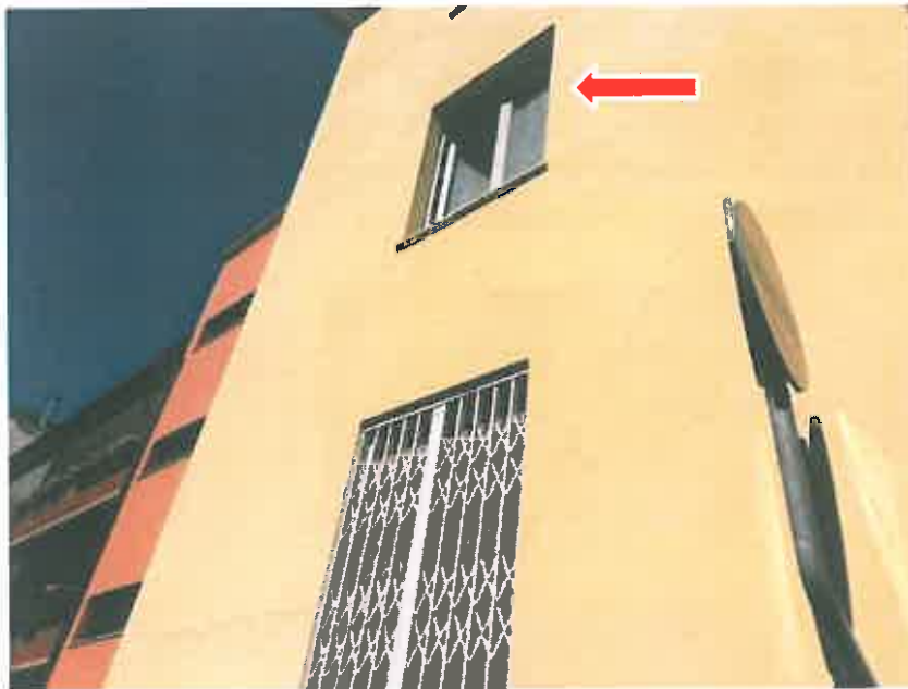
Foto n. 8 —fronte Ovest su Via Ugo Foscolo (finestra piano primo , camera da letto)
