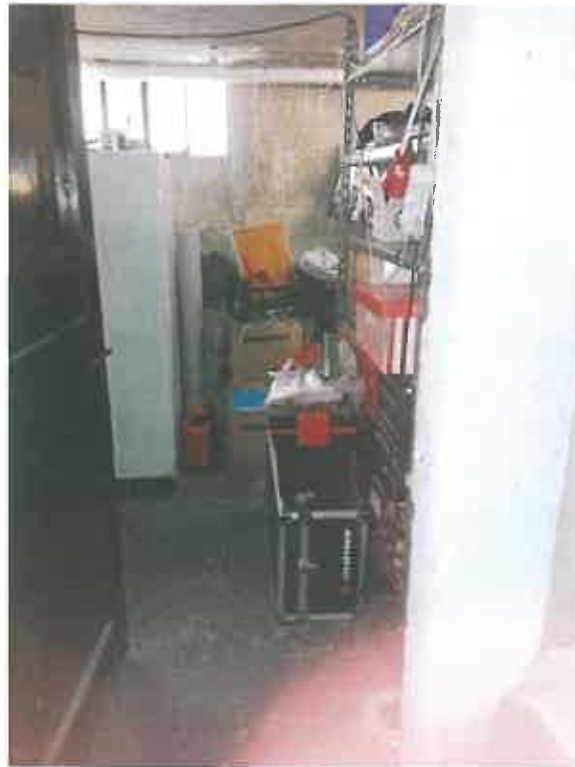
Foto n. 23 – ingresso locale cantina sub 18 piano seminterrato
