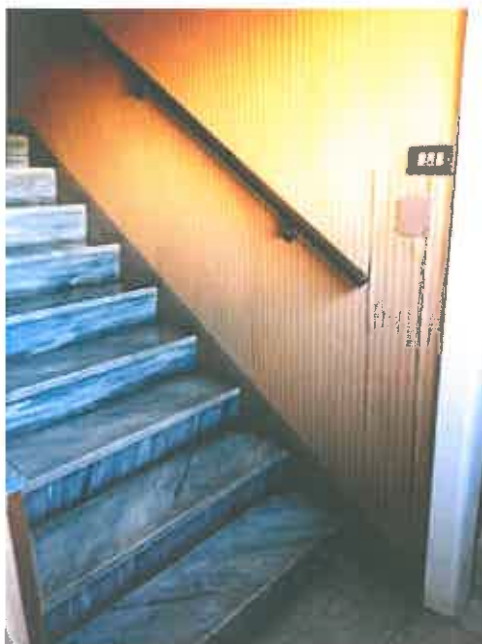
Foto n. 9 – androne ingresso e scala comune
