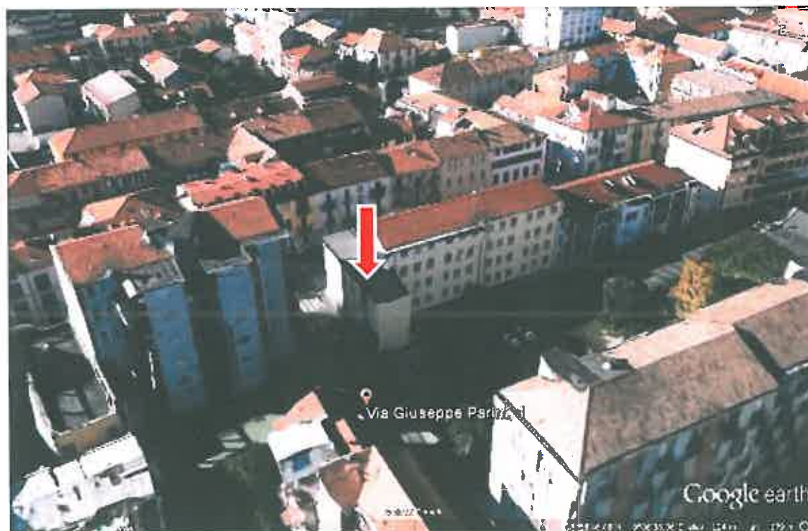
Foto n. 2 — vista aerea del complesso edilizio di via Parini 1 e via Foscolo 9/11
