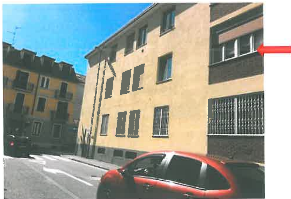
Foto n. 4 — fronte strada – piano primo
