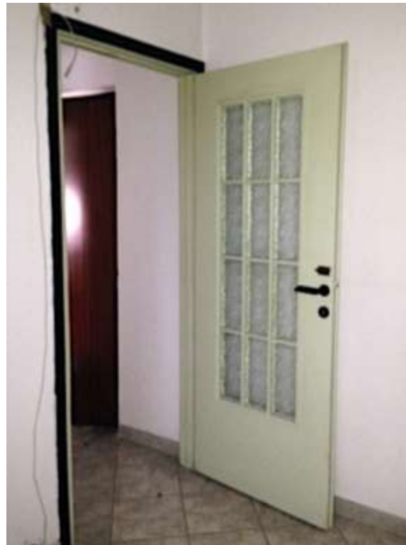
Foto: 06, dettaglio porte interne
