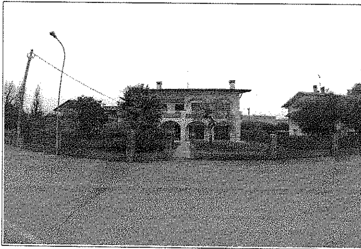
Foto 1 – vista esterna angolo nord-ovest
