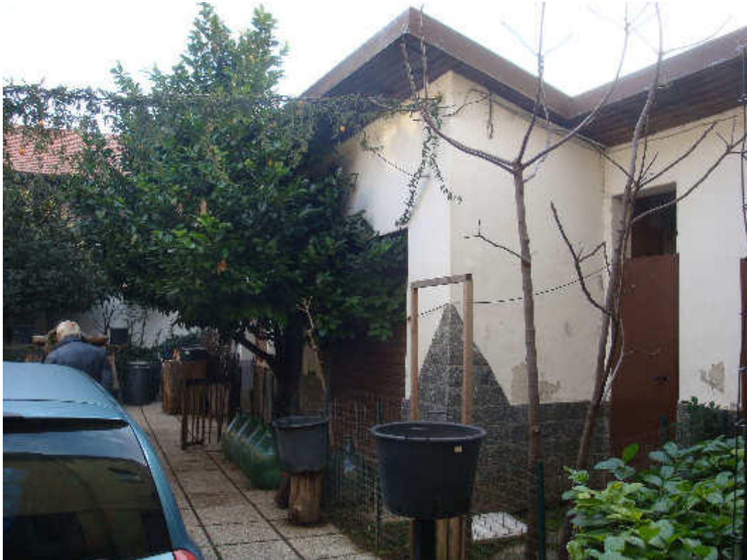
FOTO 6 – Il corpo box – prospettiva verso il fondo della corte
