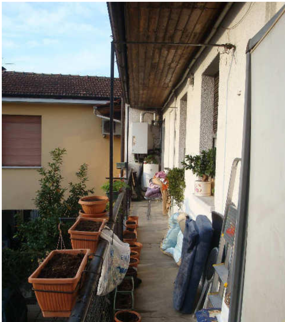
FOTO 9 – Il balcone in affaccio sulla corte interna – prospettiva verso Via Cavour
