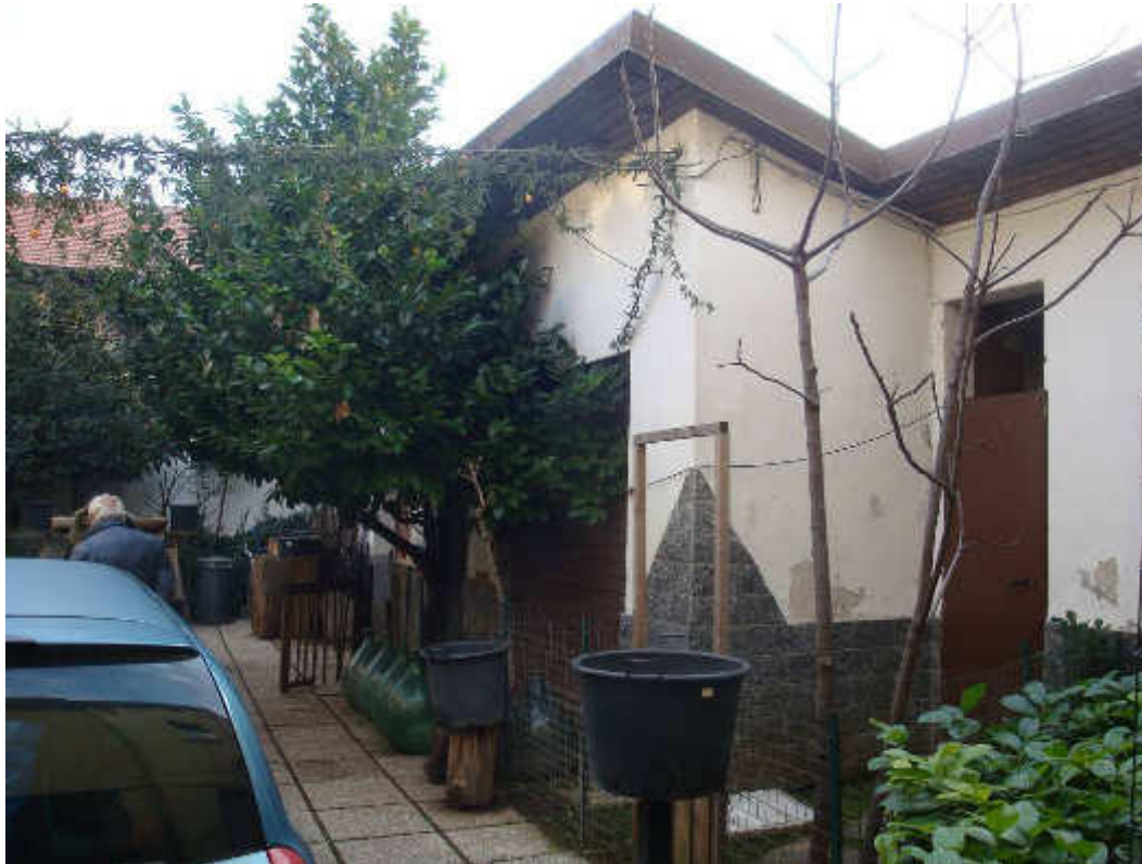
FOTO 13 – Il corpo box con in evidenza l'unità immobiliare oggetto di esecuzione
