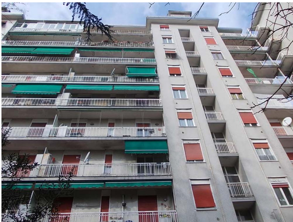
Vista del fabbricato fronte retro
