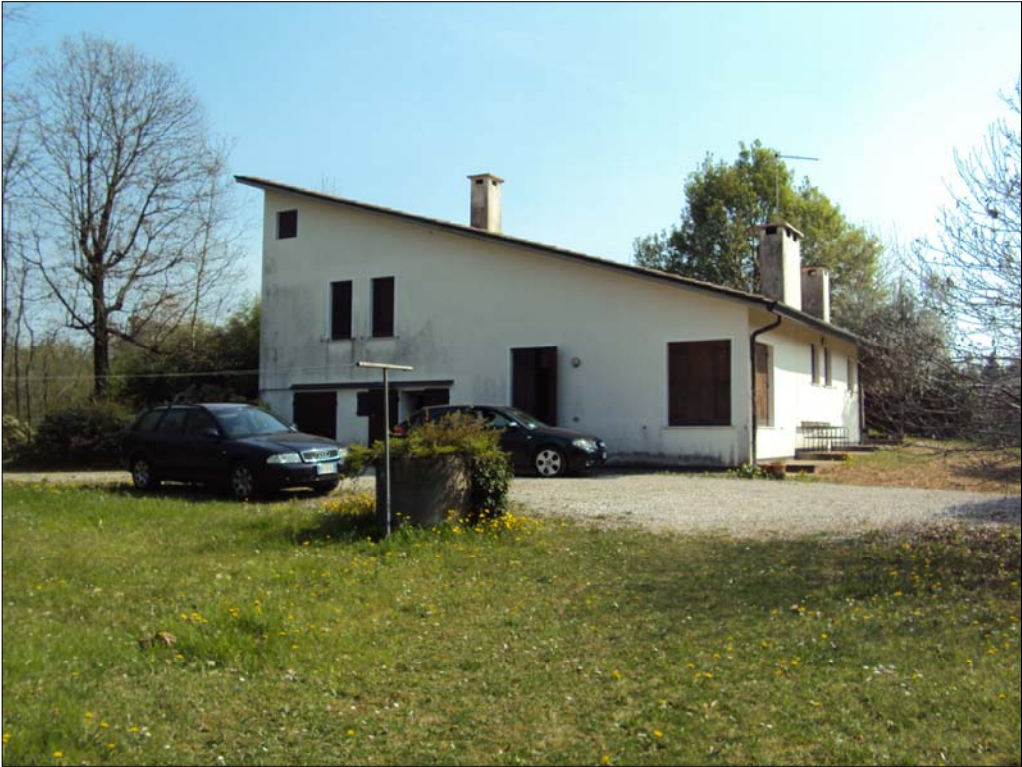
Foto n. 1: Prospetto nord - ovest
