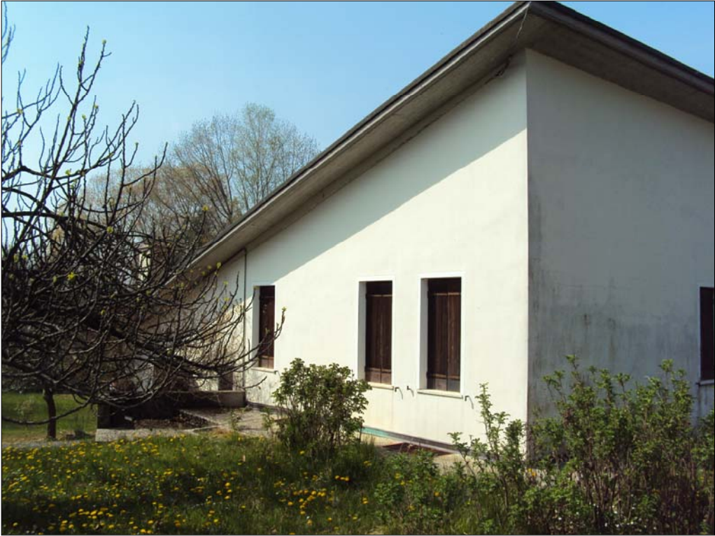
Foto n. 2: Prospetto sud - est
