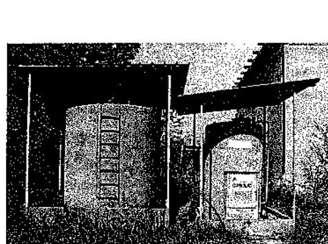
n. 2 cisterne complete di vasca di contenimento e tettoia(cespiti n. L2 e L3).
