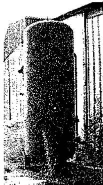
Serbatoio - Polmone capacità 6.000 l.
