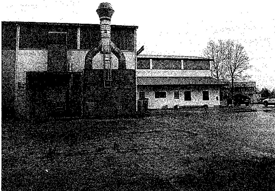
Vista prospetto sud-ovest del complesso artigianale.
