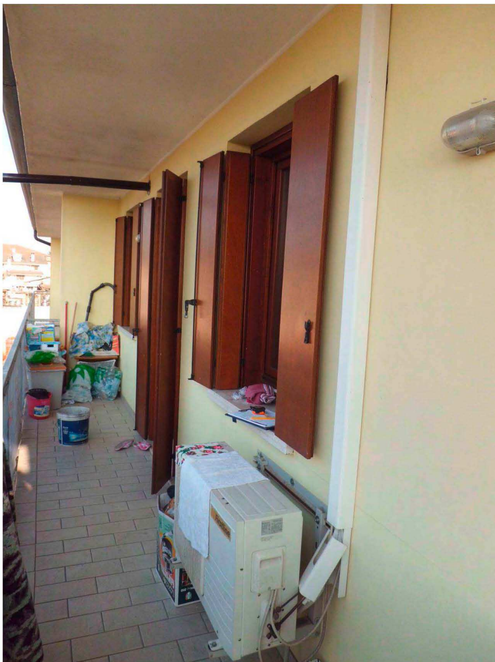
Foto n° 15 - 19/02/2015 - Comune di Pravisdomini - Foglio 11 part. 495 sub.10 - terrazza posta sul lato nord-ovest dell'edificio. Visibili in sequenza la finestra del bagno, la porta-finestra e la finestra del soggiorno. Sotto la finestra del bagno è visibile il condizionatore di cui alla precedente foto 12.
