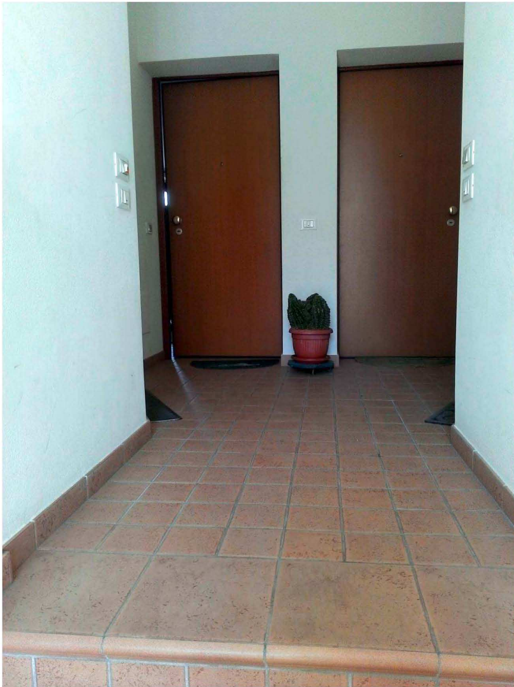
Foto n° 4 - 19/02/2015 - Comune di Pravidomini - Foglio 11 part. 495 - Pianerottolo posto al termine della scala di cui alla foto precedente . La porta d'ingresso dell'appartamento eseguito è quella a sinistra.
