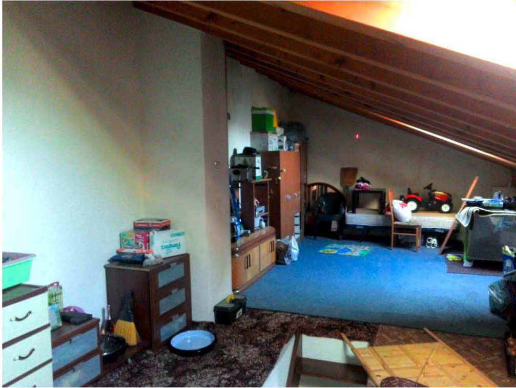
Foto n° 9 - 19/02/2015 - Comune di Pravisdomini - Foglio 11 part. 495 sub.10 - Sottotetto non abitabile formato da un unico vano. Il soffitto, formato da travi di legno, ha un'altezza variabile e non permette la posizione eretta su tutta la superficie. Sono presenti due lucernari che favoriscono l'entrata di luce naturale.
