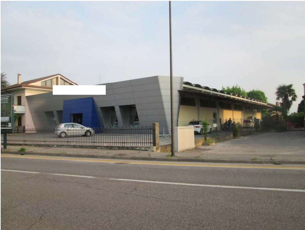
FOTO n°1.: visione esterna fabbricato
