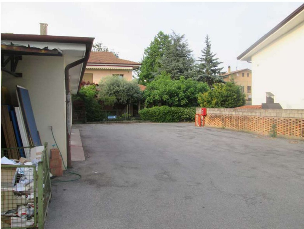
FOTO n°4.: visione esterna fabbricato
