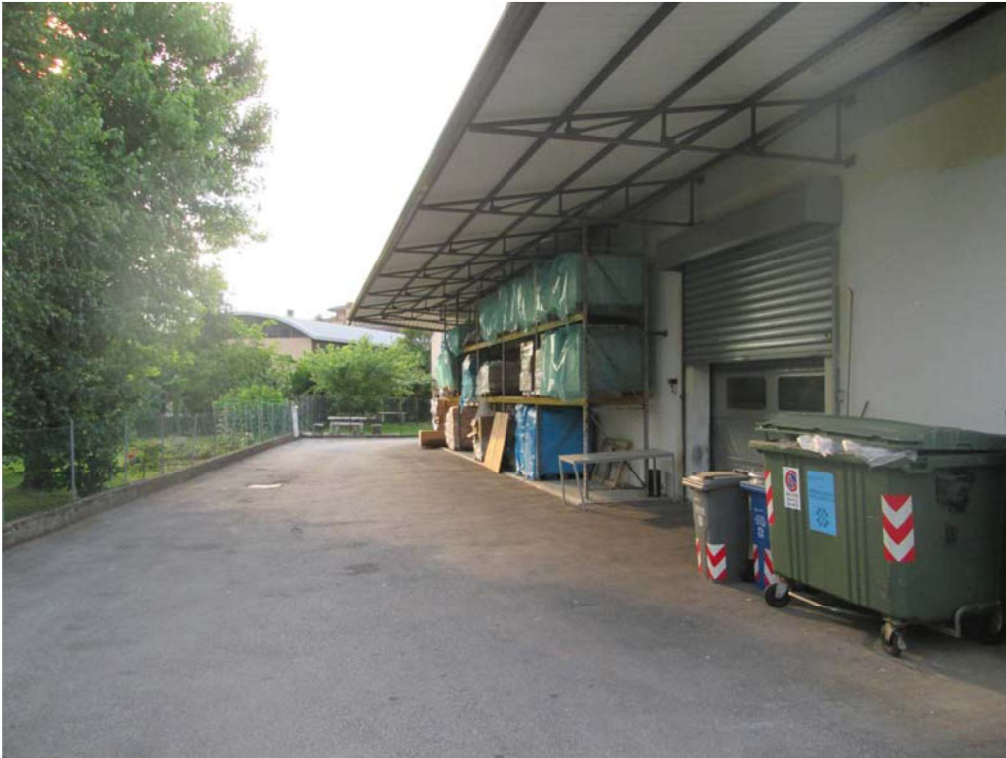
FOTO n°3.: visione esterna fabbricato
