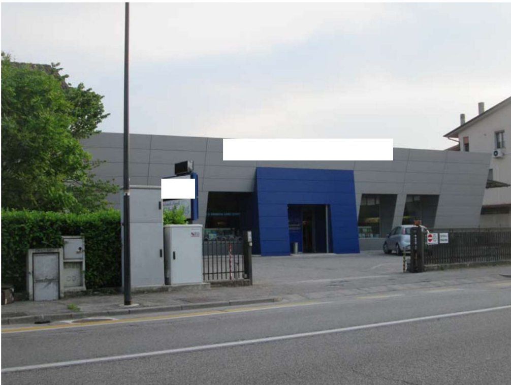
FOTO n°2.: visione esterna fabbricato
