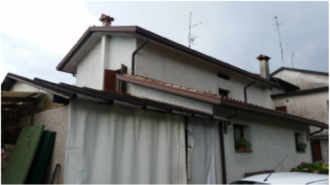
Foto 3 - prospetto laterale con ampliamento garage abusivo
