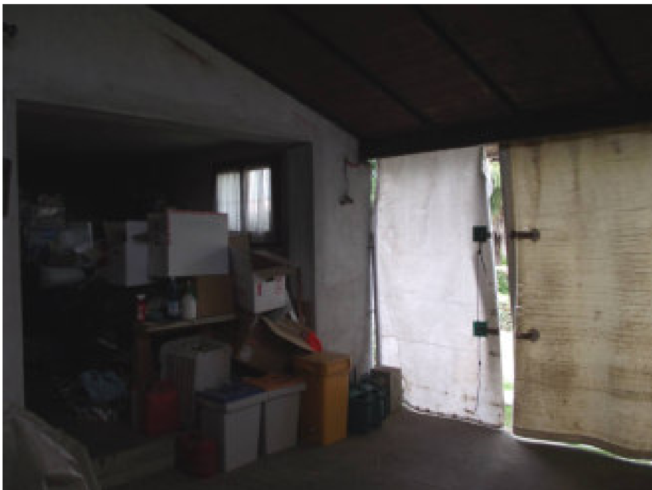
Foto 13 - Garage e magazzino (ampliamento abusivo)
