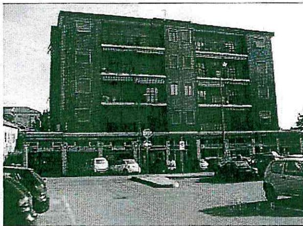
Foto 1. Prospetto su via Canazza
