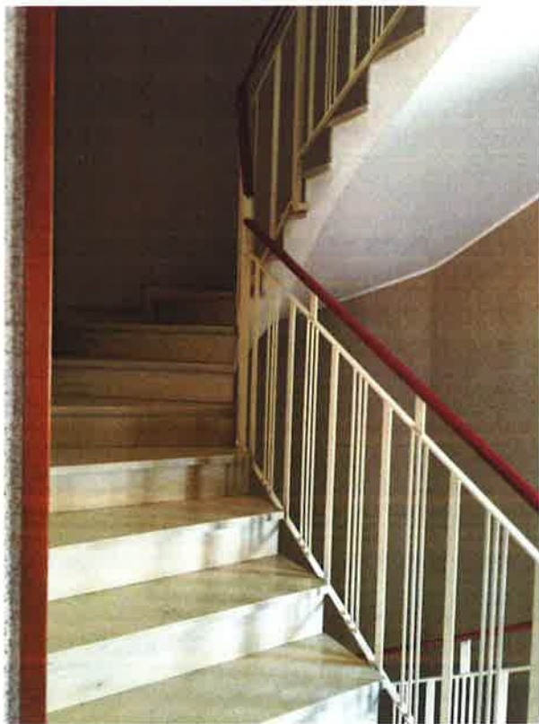
Vista vano scala comune
