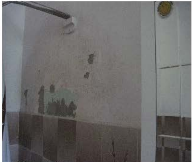
Umidità/infiltrazione Bagno
