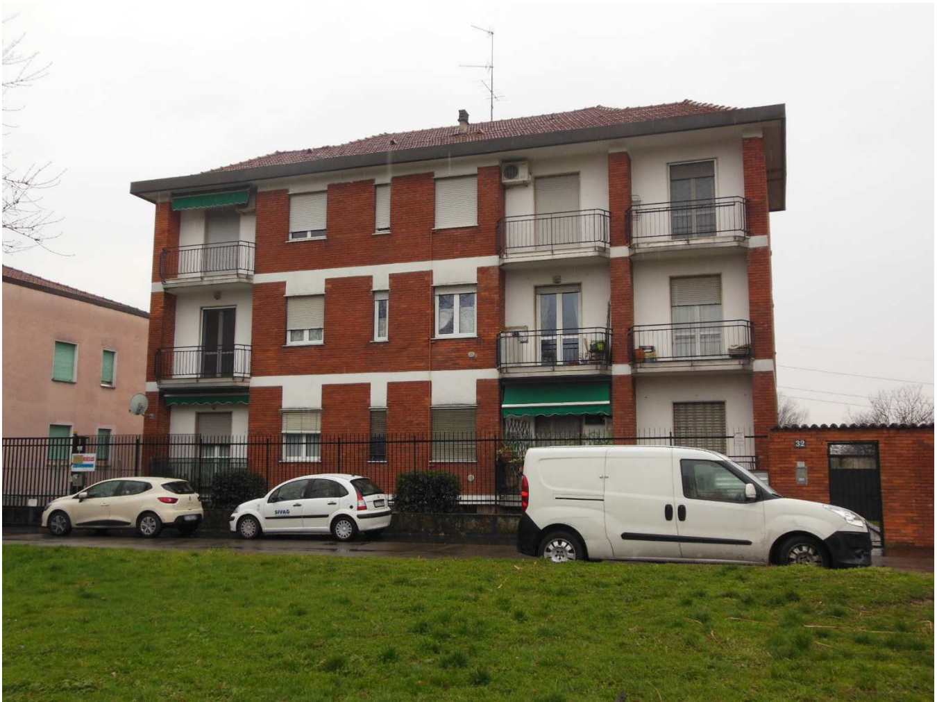
Edificio di Via Barbiera 32
