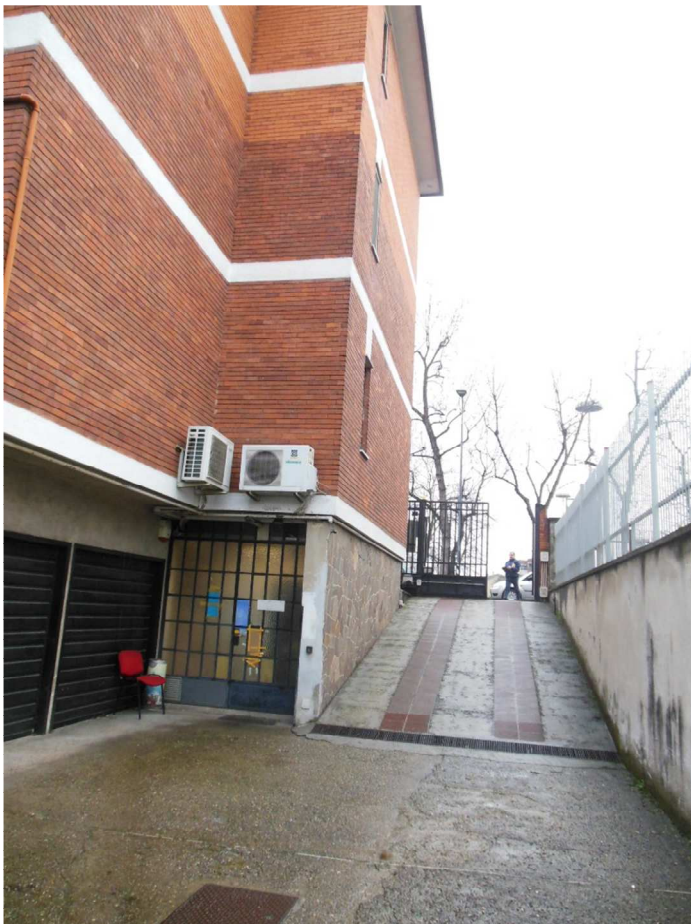
Vista rampa di accesso e portone di ingresso
