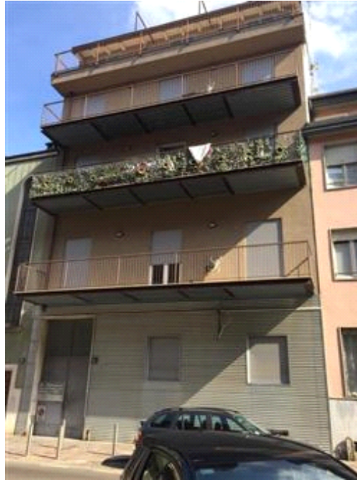
Prospetto su Via Sercognani; unico affaccio unità immobiliare al piano primo - sub 702
