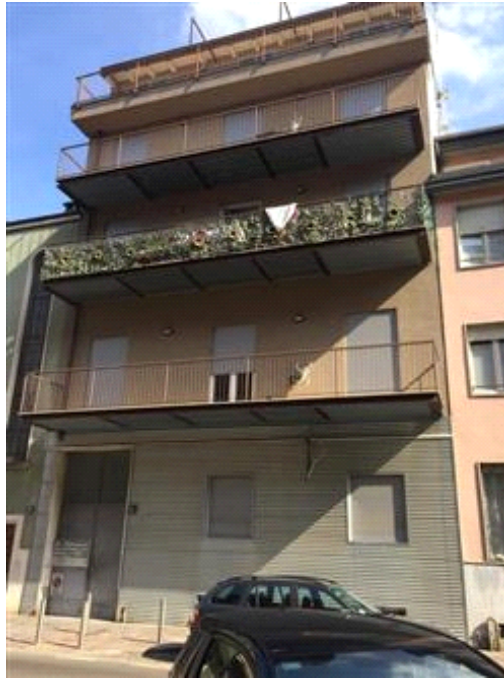
Prospetto su Via Sercognani; unico affaccio unità immobiliare al piano rialzato - sub 710
