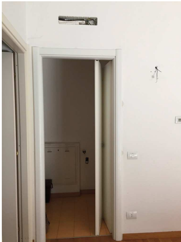
Rilievo fotografico - 7 giugno 2017 - sub 702 - Piano primo
