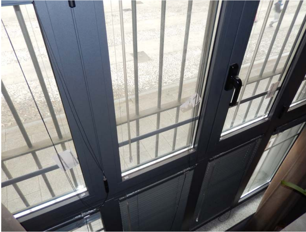
FOTO 16: Interno dell'unità pignorata – Dettaglio dei serramenti.
