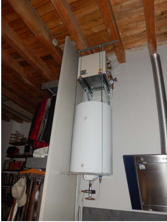
FOTO 9: Interno dell'unità pignorata – Dettaglio del boiler elettrico per la produzione di acqua calda sanitaria e della soprastante unità di riscaldamento/raffrescamento funzionante ad acqua.
