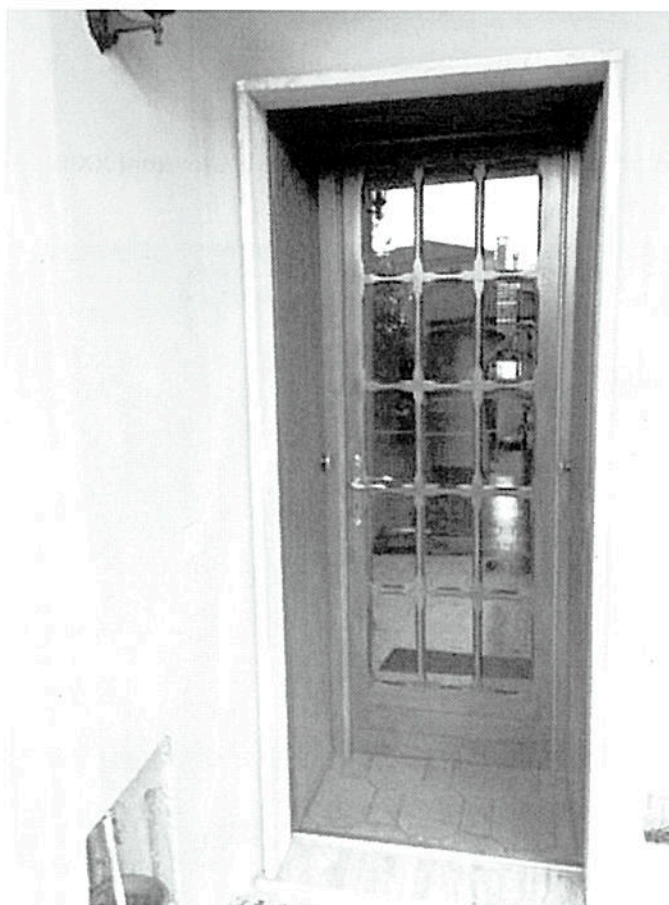
Pianerottolo di ingresso al piano primo
