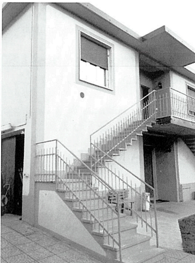
Vista dal giardino Ingresso al locale deposito al pianon terra e scala di accesso al piano primo
