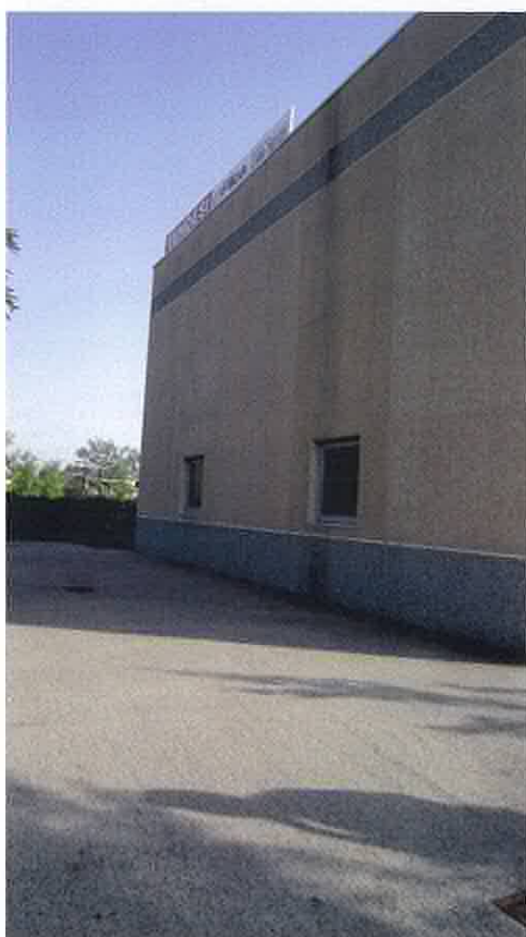
vista laterale del capannone
