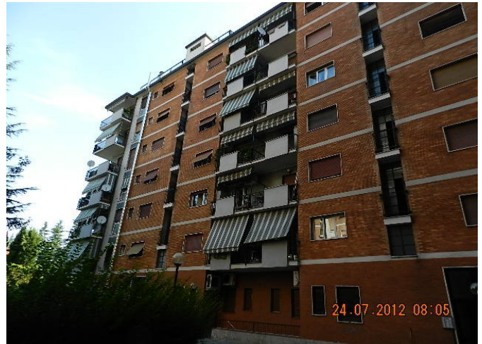
Facciata su cortile
