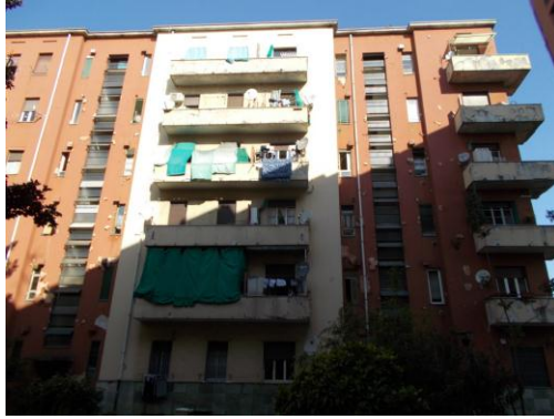
8. Facciata il verso cortile interno
