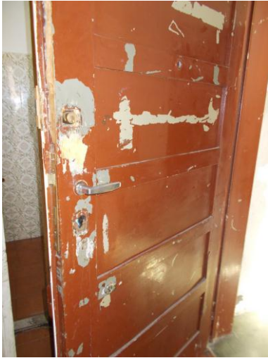
13. Particolare porta di ingresso
