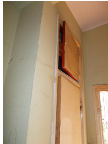
18. Ripostiglio a muro
