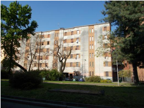
1. Facciata esterna su pubblica via
