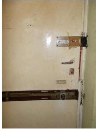
14. Particolare porta di ingresso
