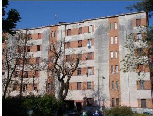
2. Facciata esterna su pubblica via
