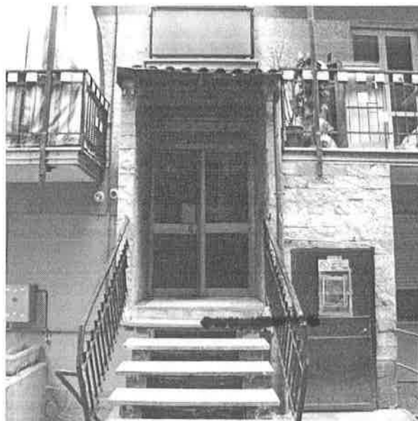
Portone di Ingresso del Fabbricato – scala E
