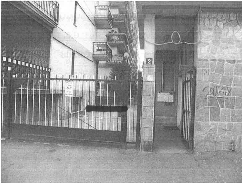
Cancello di Accesso al Fabbricato
